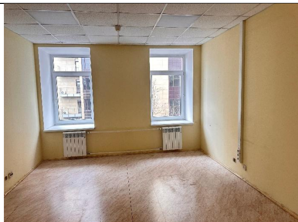
Фото № 22 – Внутреннее состояние помещения
