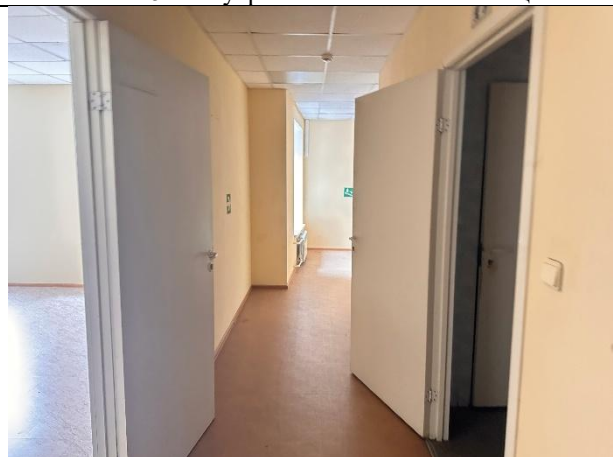
Фото № 27 – Внутреннее состояние помещения
