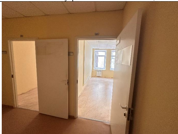
Фото № 17 – Внутреннее состояние помещения
