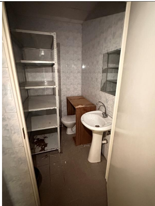
Фото № 30 – Внутреннее состояние помещения
