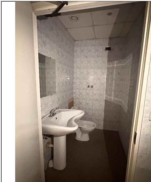
Фото № 29 – Внутреннее состояние помещения
