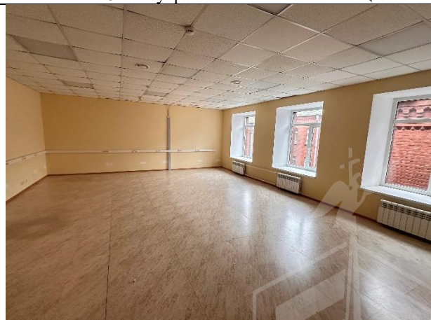
Фото № 28 – Внутреннее состояние помещения
