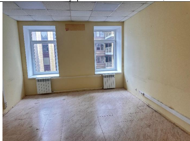
Фото № 24 – Внутреннее состояние помещения
