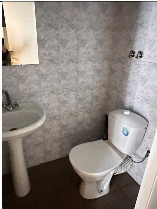
Фото № 16 – Внутреннее состояние помещения
