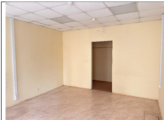
Фото № 21 – Внутреннее состояние помещения
