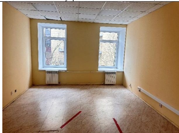
Фото № 23 – Внутреннее состояние помещения
