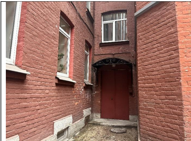
Фото № 7 – Общий вход со двора
