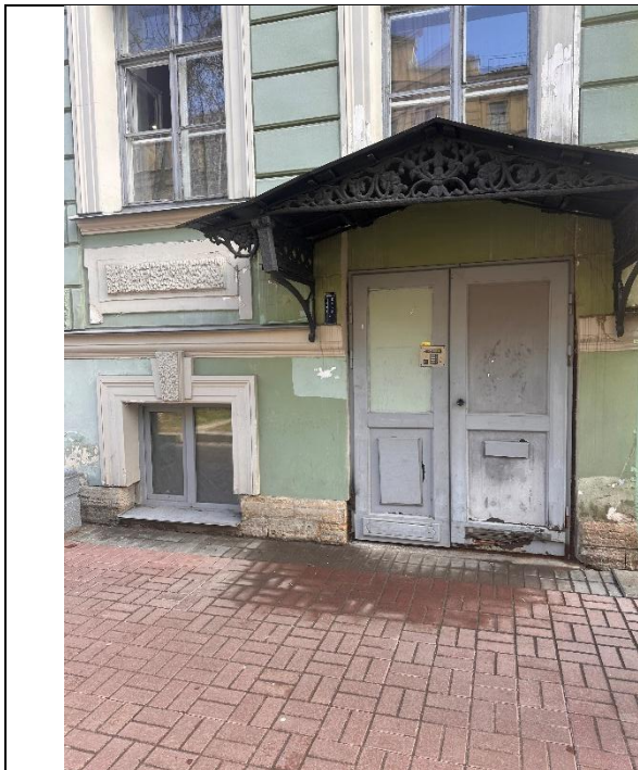
Фото № 5 – Вход в помещение с улицы
