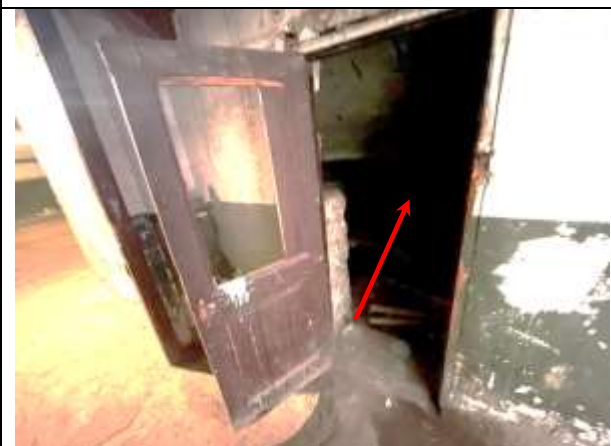
Фото 25. Типичное состояние Объекта оценки, входная группа Объекта оценки, общий со двора
