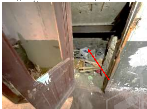
Фото 26. Типичное состояние Объекта оценки, входная группа Объекта оценки, общий со двора
