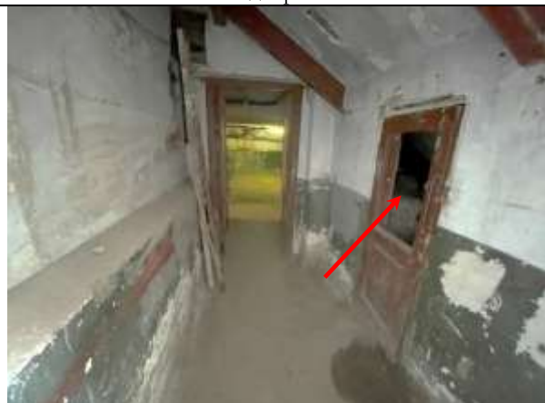
Фото 24. Типичное состояние Объекта оценки, входная группа Объекта оценки, общий со двора
