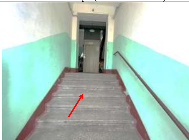
Фото 20. Лестничный проем здания расположения Объекта оценки
