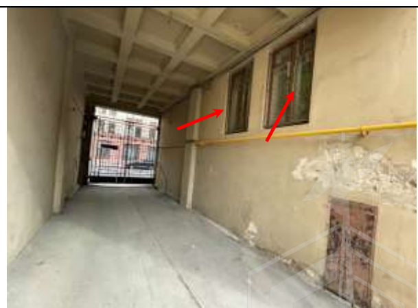
Фото 14. Проход через арку к Объекту оценки, оконная группа Объекта оценки (помещение 16Н)
