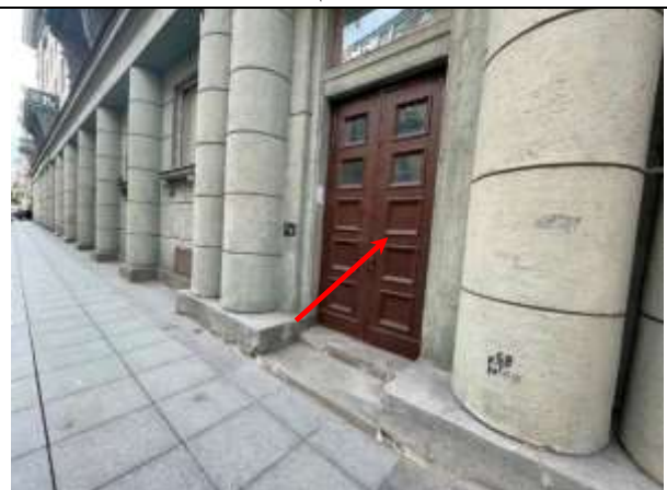
Фото 34. Входная группа Объекта оценки, общий вход с улицы
