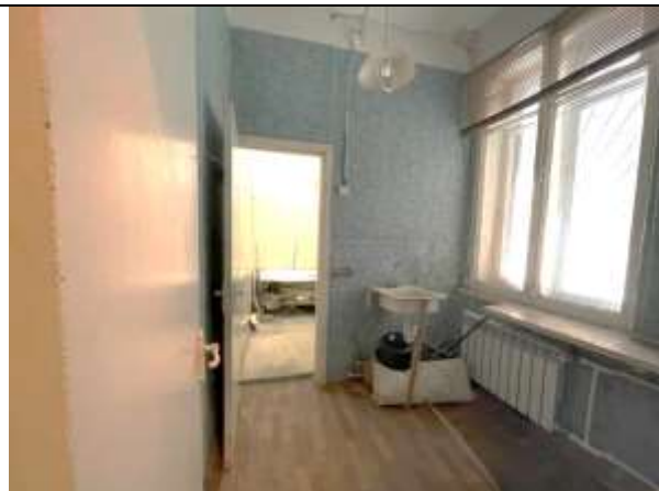
Фото 29. Типичное состояние Объекта оценки
