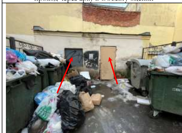
Фото 25. Входная и оконная группа Объекта оценки
