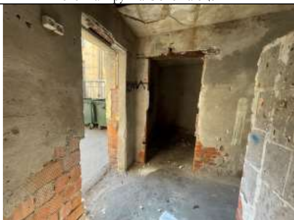
Фото 27. Типичное состояние Объекта оценки
