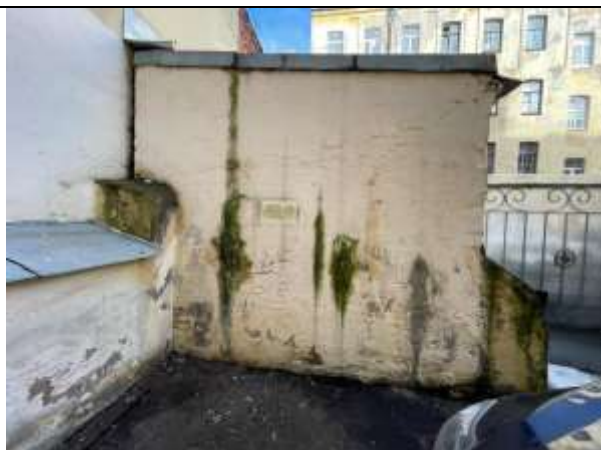
Фото 24. Вид здания расположения Объекта оценки
