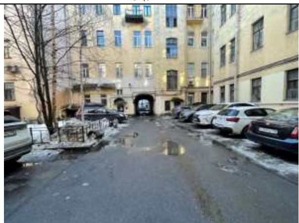
Фото 20. Внутриворовая территория Объекта оценки
