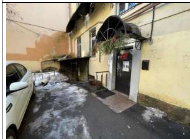
Фото 19. Внутриворовая территория Объекта оценки
