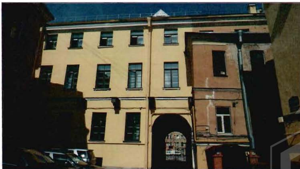
3. Дворовые фасады северной части здания. Вид с юго-востока.
