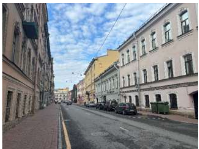
Фото 8. Ближайшее окружение Объекта оценки (Шпалерная улица)
