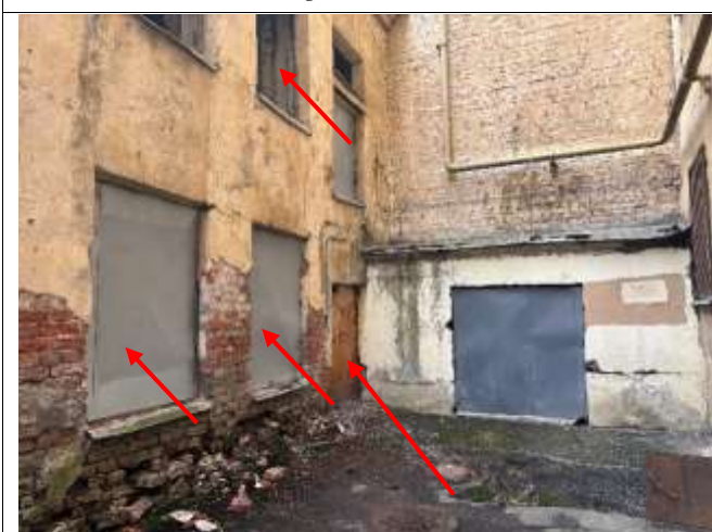
Фото 35. Входная и оконная группа Объекта оценки
