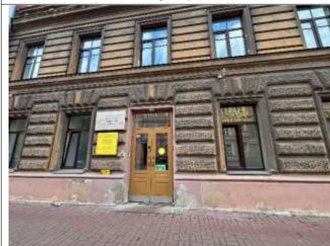
Фото 11. Ближайшее окружение Объекта оценки (Шпалерная улица)
