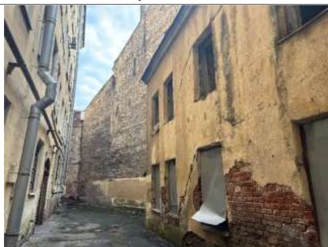
Фото 34. Вид здания расположения Объекта оценки
