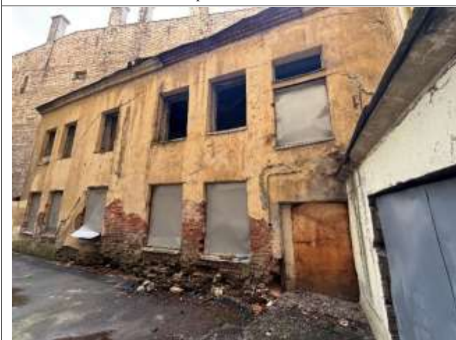
Фото 33. Вид здания расположения Объекта оценки
