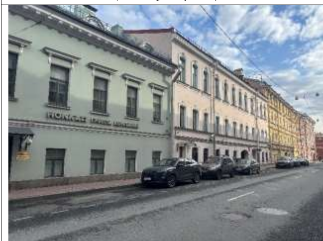
Фото 9. Ближайшее окружение Объекта оценки (Шпалерная улица)
