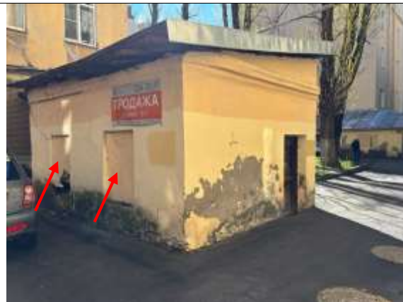
Фото 24. Оконные проемы Объекта оценки
