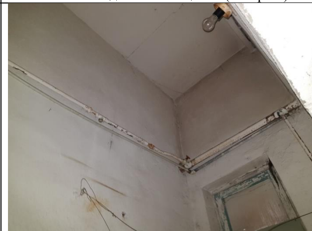
Фото 48. Вид Объекта оценки (литера Б)
