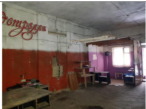
Фото 38. Вид Объекта оценки (литера Б)
