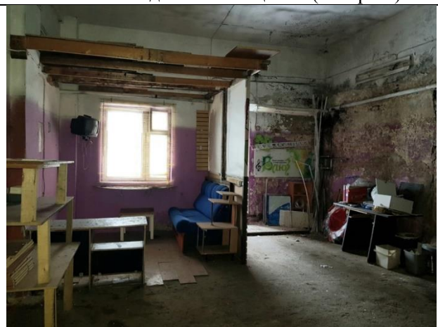
Фото 42. Вид Объекта оценки (литера Б)
