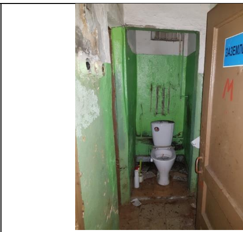
Фото 46. Вид Объекта оценки (литера Б)
