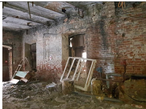
Фото 29. Вид Объекта оценки (литера А)
