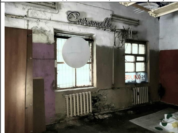
Фото 41. Вид Объекта оценки (литера Б)
