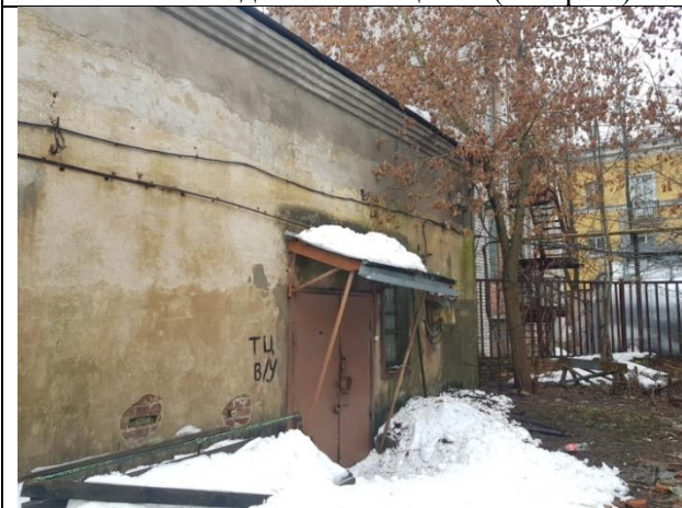
Фото 43. Вид Объекта оценки (литера Б)
