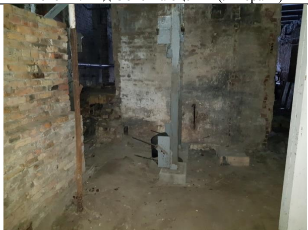
Фото 24. Вид Объекта оценки (литера А)
