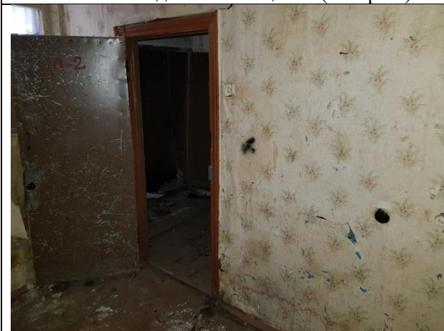
Фото 51. Вид Объекта оценки (литера Б)
