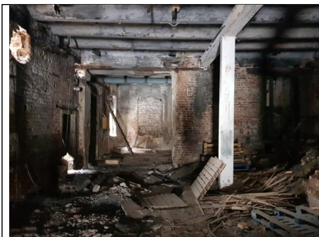
Фото 21. Вид Объекта оценки (литера А)
