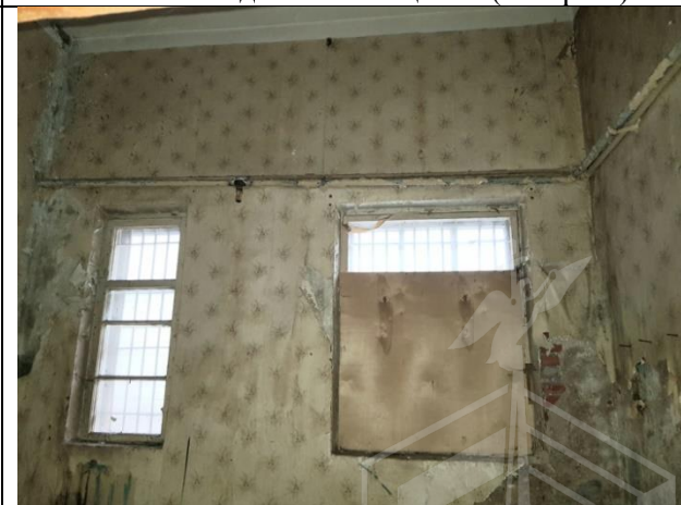
Фото 52. Вид Объекта оценки (литера Б)
