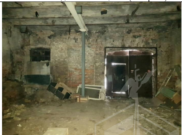
Фото 28. Вид Объекта оценки (литера А)
