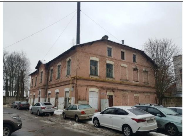
Фото 8. Вид Объекта оценки (литера А)
