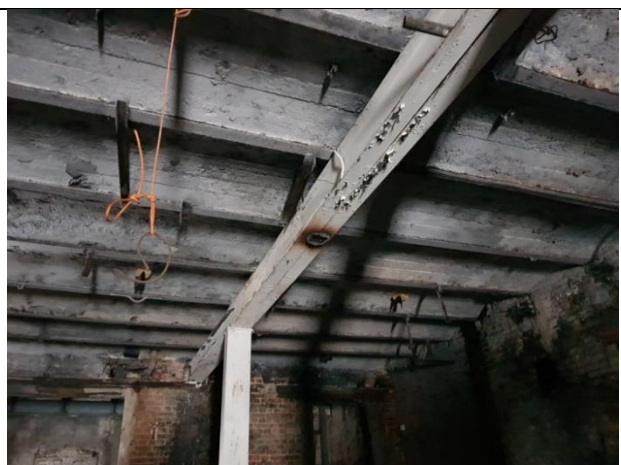
Фото 22. Вид Объекта оценки (литера А)
