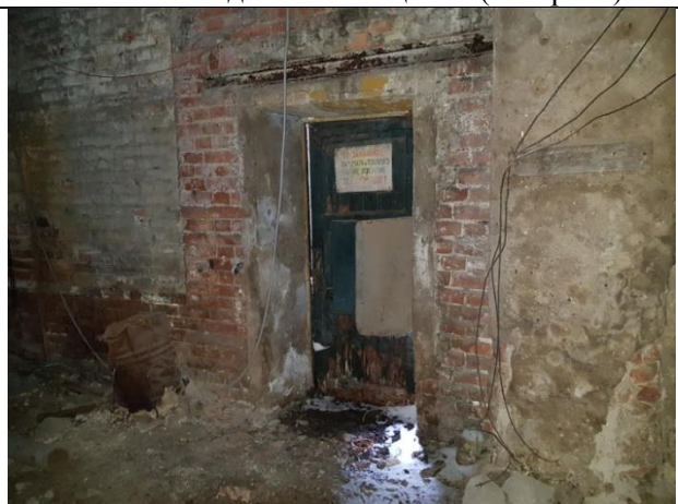
Фото 26. Вид Объекта оценки (литера А)
