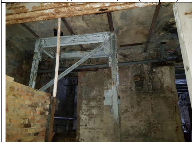
Фото 23. Вид Объекта оценки (литера А)
