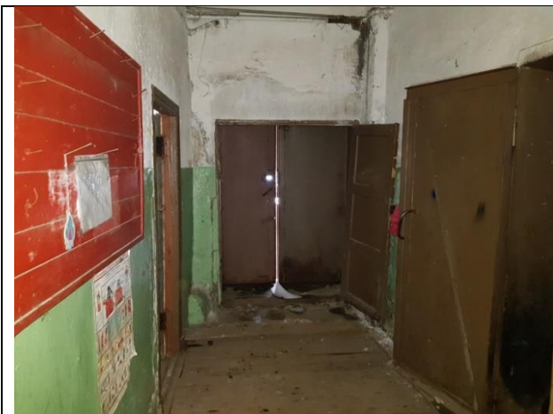
Фото 45. Вид Объекта оценки (литера Б)
