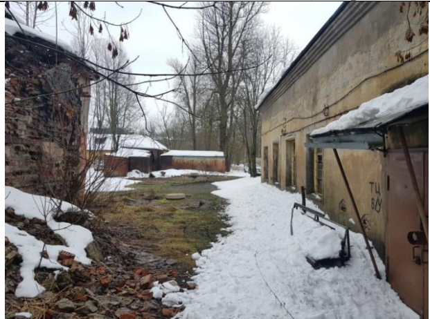
Фото 34. Вид Объекта оценки (литера Б)
