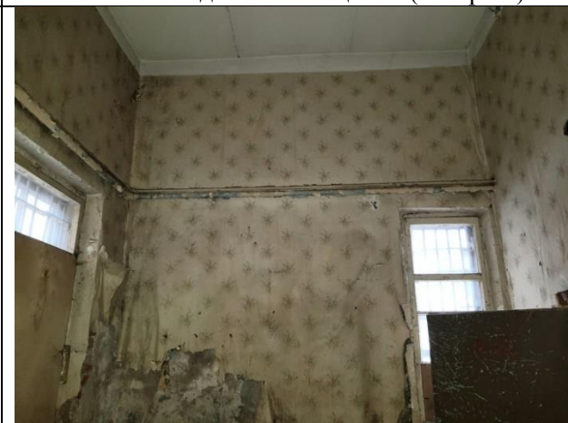
Фото 50. Вид Объекта оценки (литера Б)
