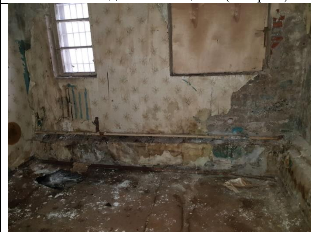
Фото 49. Вид Объекта оценки (литера Б)
