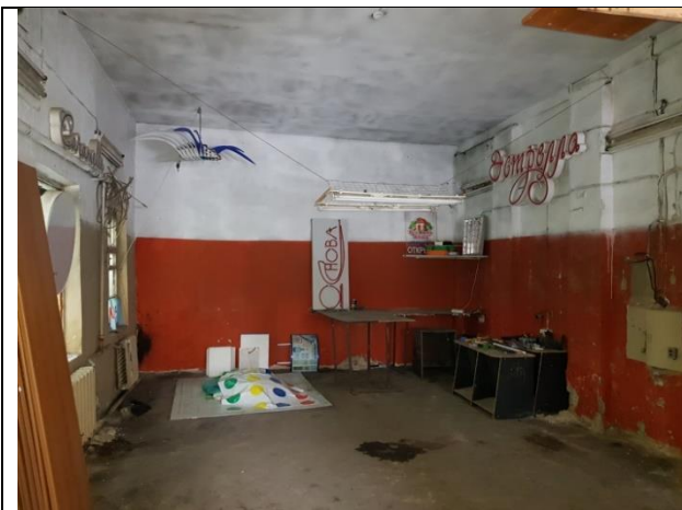
Фото 37. Вид Объекта оценки (литера Б)
