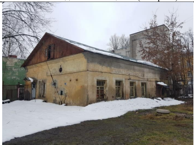
Фото 32. Вид Объекта оценки (литера Б)
