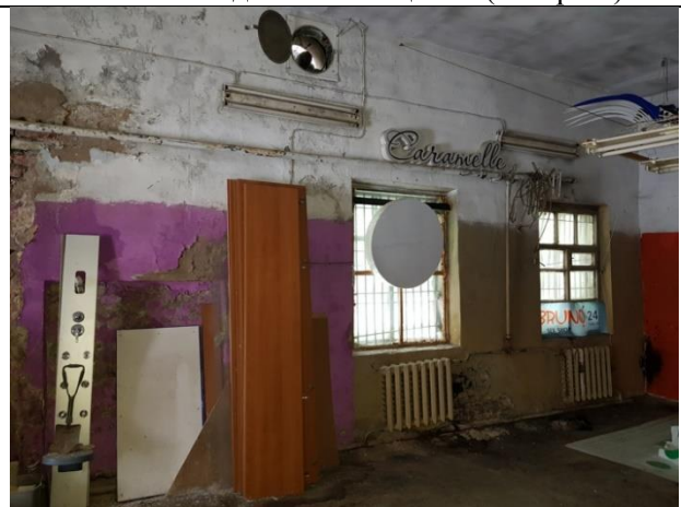
Фото 40. Вид Объекта оценки (литера Б)
