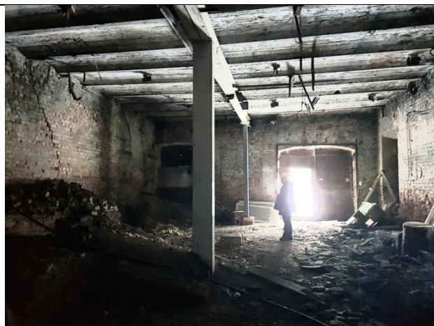
Фото 30. Вид Объекта оценки (литера А)
