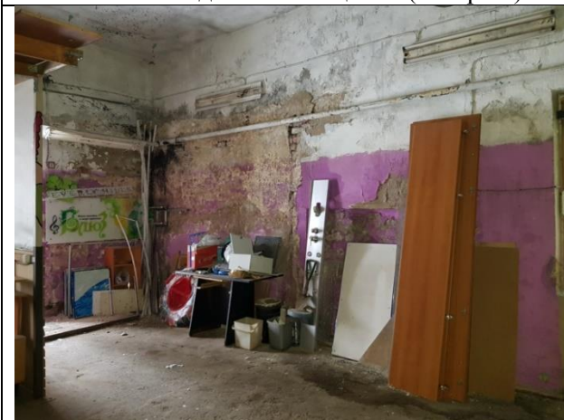
Фото 39. Вид Объекта оценки (литера Б)
