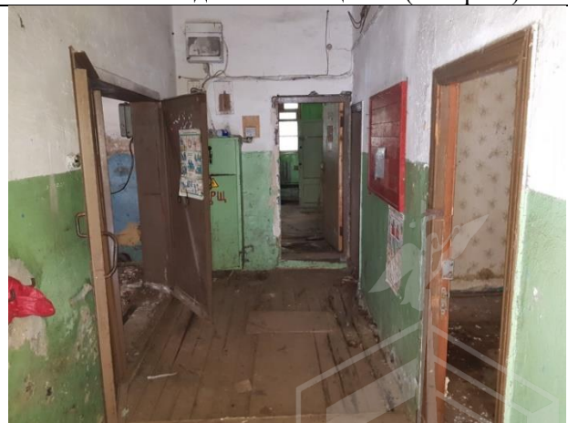
Фото 44. Вид Объекта оценки (литера Б)
