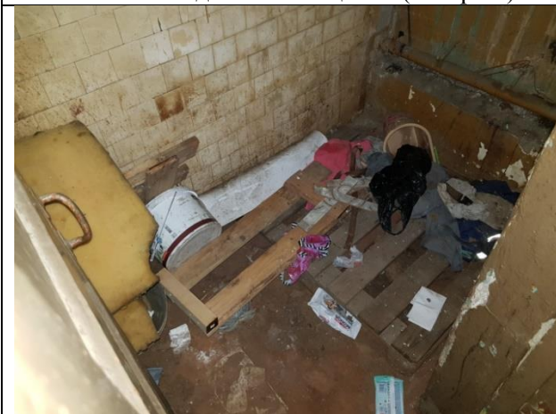
Фото 47. Вид Объекта оценки (литера Б)
