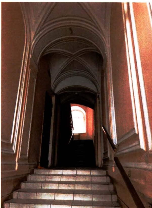
13. Помещение Л-2 объекта культурного наследия. Фото выполнено 19.04.2024
