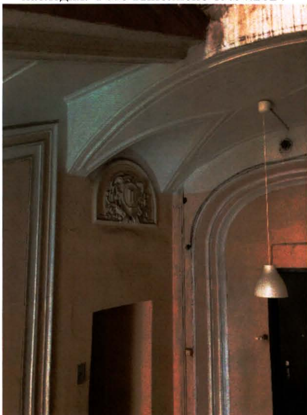
19. Помещение Л-2 объекта культурного наследия. Фото выполнено 19.04.2024
