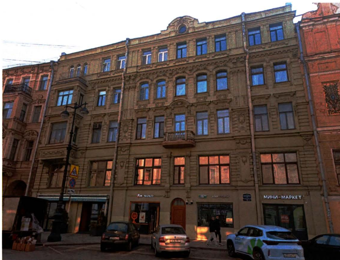
1. Северо-западный фасад объекта культурного наследия. Фото выполнено 24.03.2025 г.
