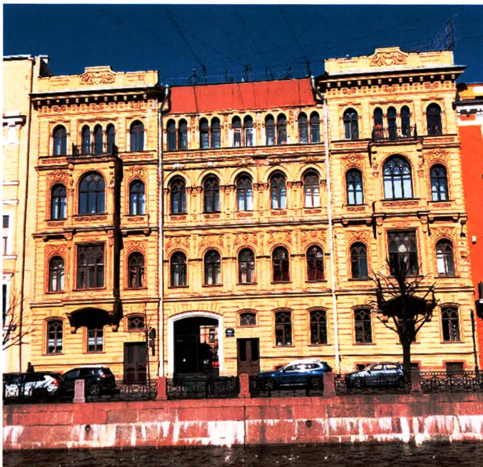
2. Юго-восточный фасад объекта культурного наследия. Фото выполнено 11.04.2024 г.
