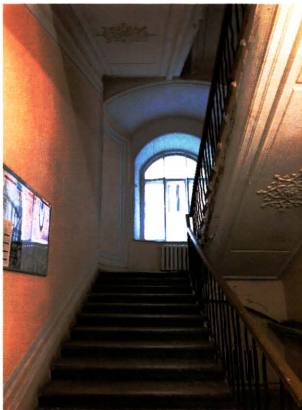
18. Помещение Л-2 объекта культурного наследия. Фото выполнено 19.04.2024
