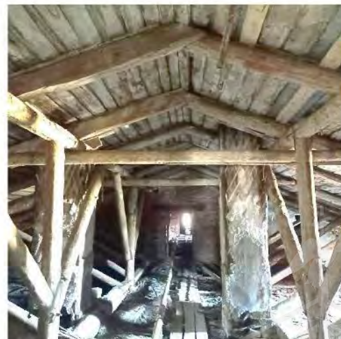
Фото 30. Вид чердачного (подкровельного) пространства и стропильной системы
