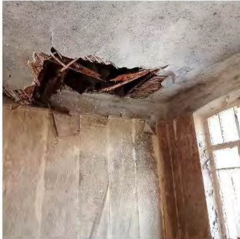
Фото 25. Вид на одно из помещений 3 этажа
