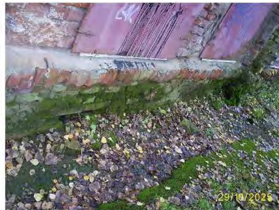
Фото 73. Часть северного фасада
