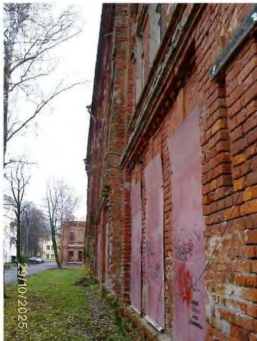
Фото 70. Часть северного фасада
