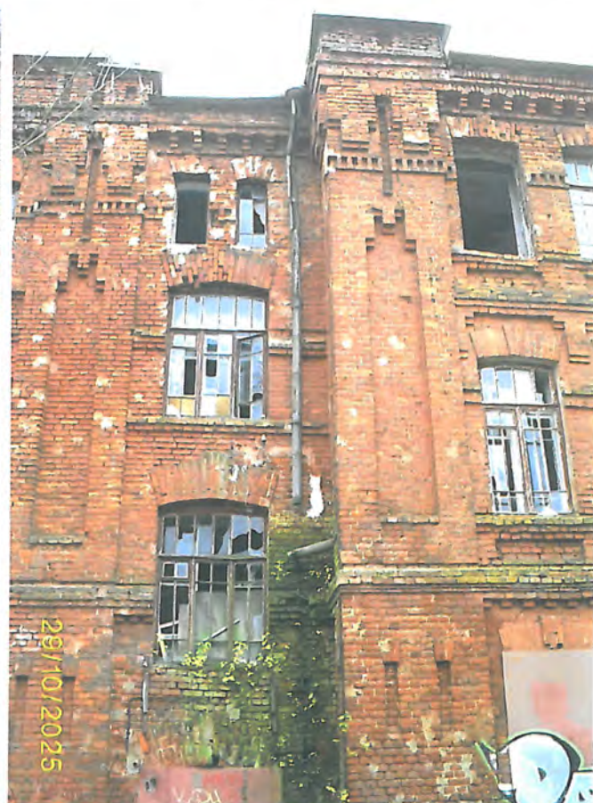
Фото 77. Часть северного фасада
