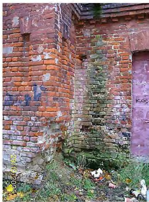
Фото 44. Часть южного фасада
