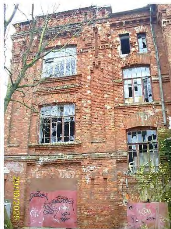
Фото 75. Часть северного фасада
