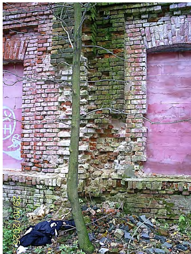
Фото 53. Часть южного фасада
