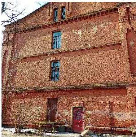
Фото 9. Вид на часть восточного фасада
