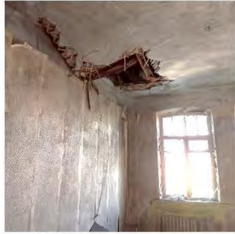
Фото 26. Вид на одно из помещений 3 этажа
