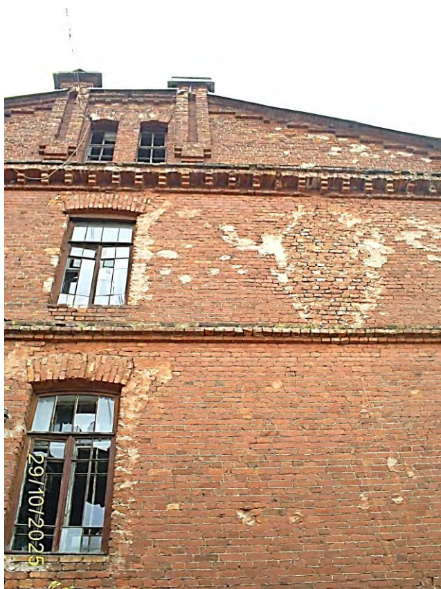
Фото 39. Часть восточного фасада
