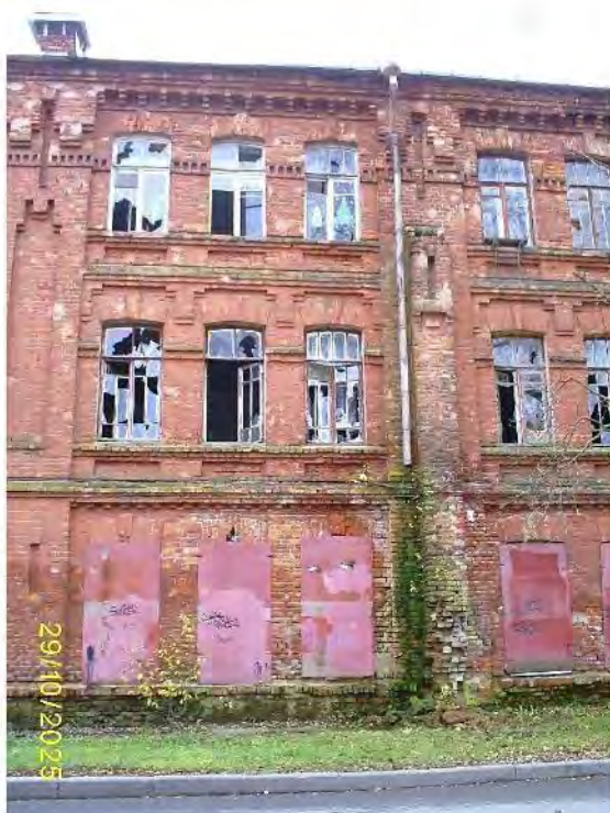
Фото 74. Часть северного фасада
