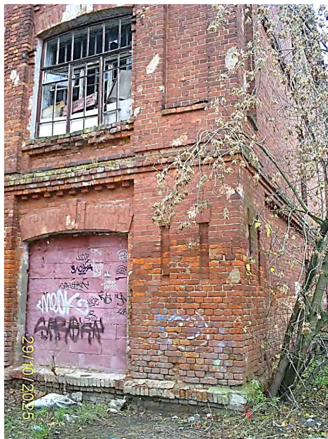
Фото 42. Часть южного фасада
