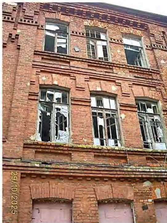
Фото 56. Часть южного фасада
