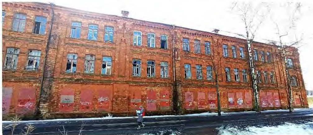
Фото 3. Вид на западную часть северного фасада
