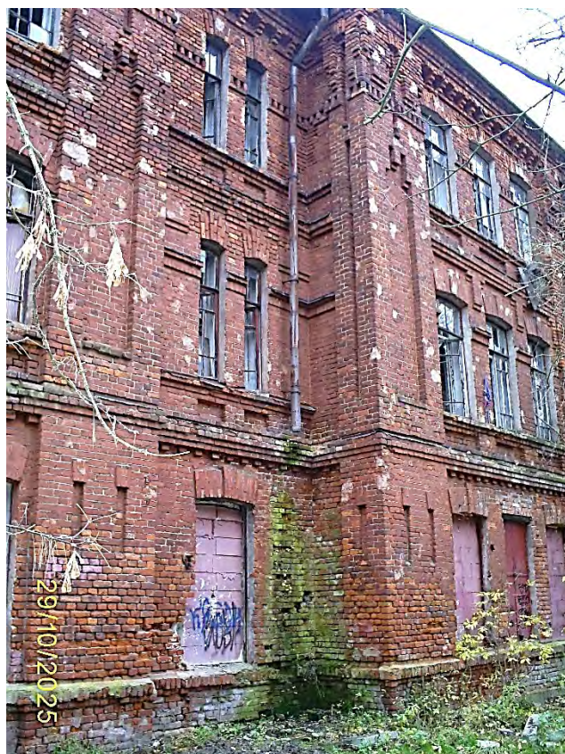
Фото 57. Часть южного фасада
