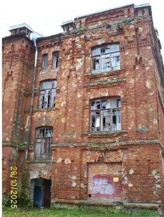
Фото 66. Часть северного фасада
