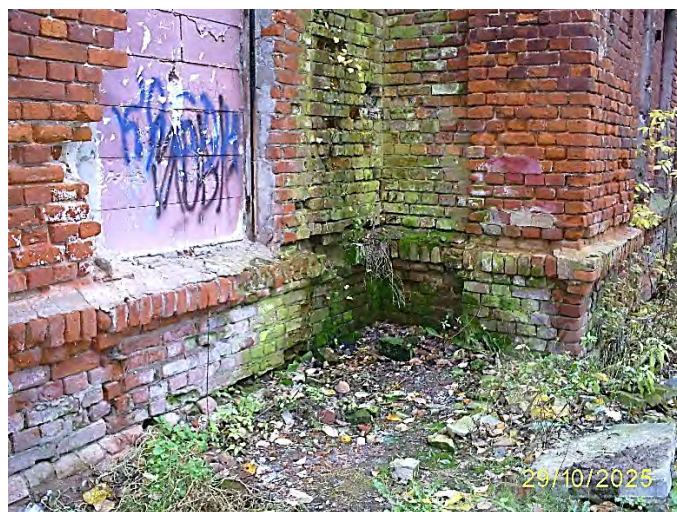
Фото 59. Часть южного фасада
