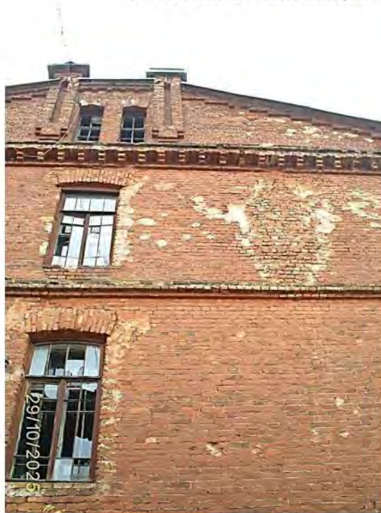
Фото 39. Часть восточного фасада
