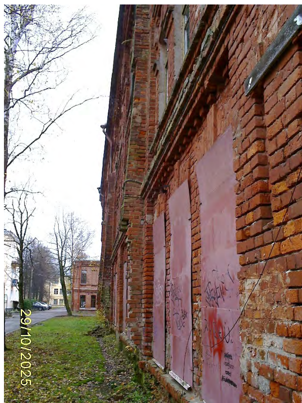
Фото 70. Часть северного фасада
