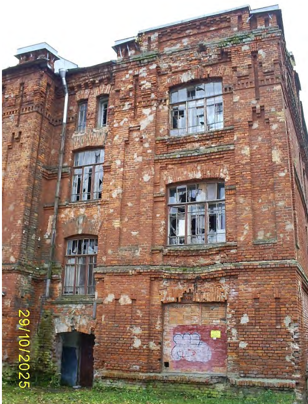
Фото 66. Часть северного фасада
