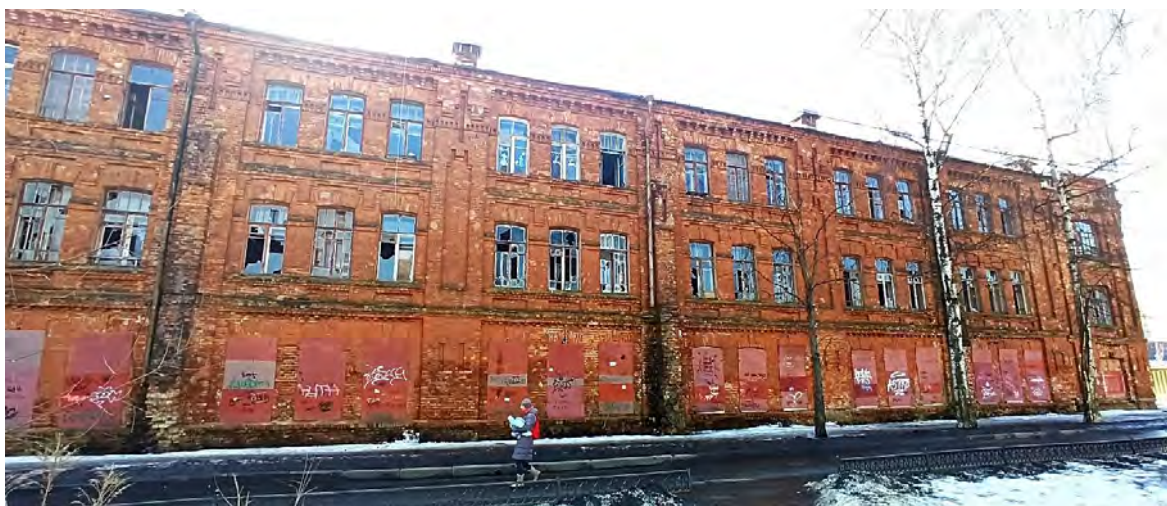
Фото 3. Вид на западную часть северного фасада
