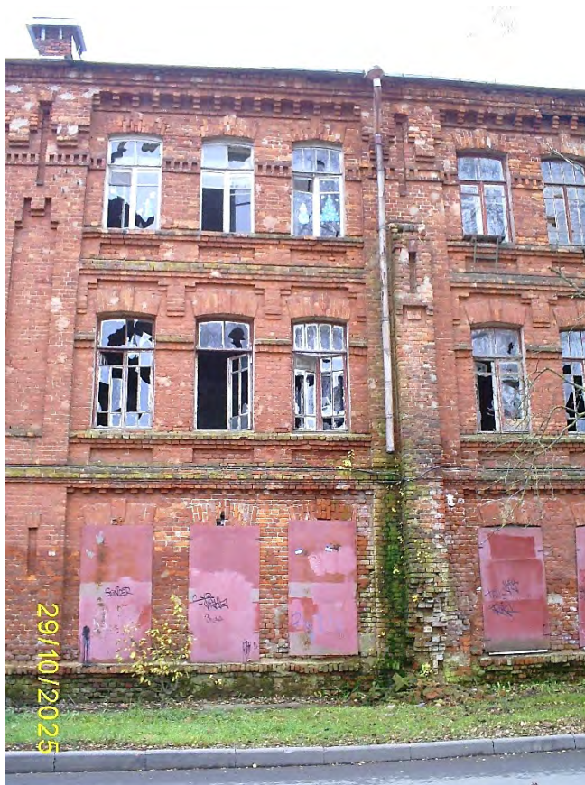
Фото 74. Часть северного фасада
