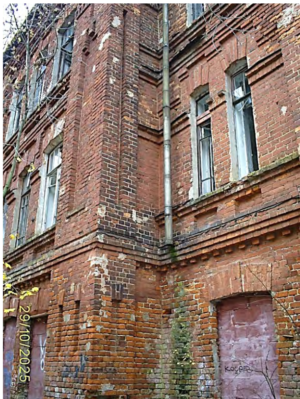
Фото 43. Часть южного фасада
