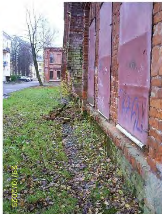
Фото 71. Часть северного фасада
