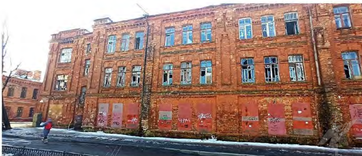
Фото 2. Вид на восточную часть северного фасада
