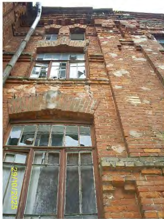
Фото 69. Часть северного фасада
