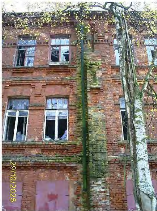
Фото 72. Часть северного фасада
