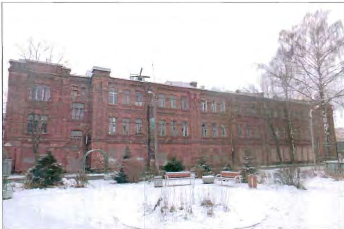
1. Общий вид северного фасада.
