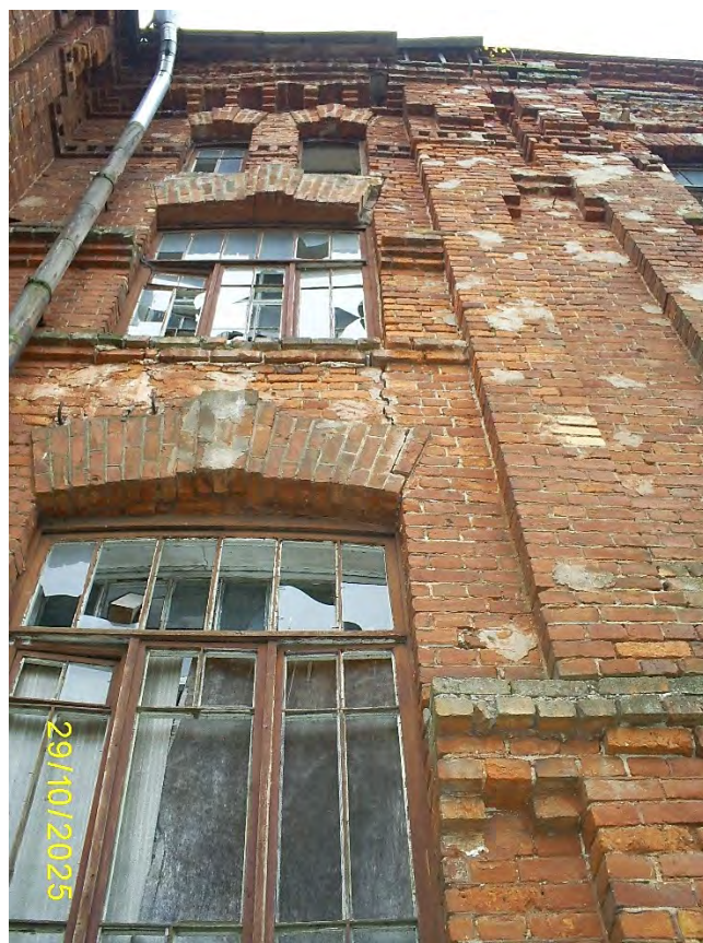
Фото 69. Часть северного фасада
