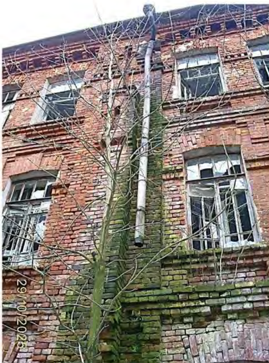
Фото 54. Часть южного фасада
