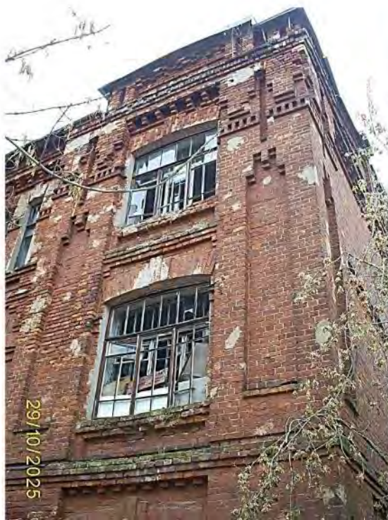
Фото 41. Часть южного фасада
