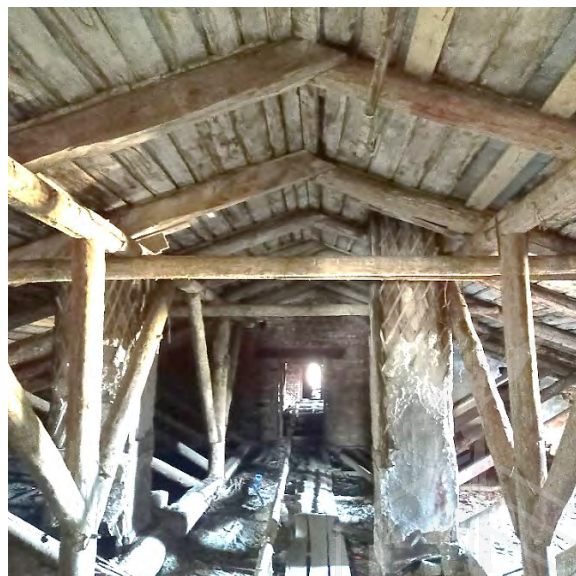
Фото 30. Вид чердачного (подкровельного) пространства и стропильной системы
