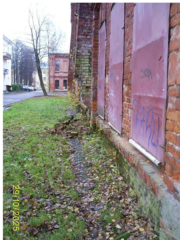
Фото 71. Часть северного фасада
