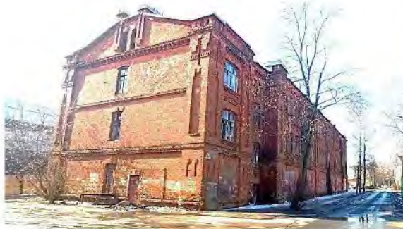
Фото 7. Вид на восточный и северный фасады
