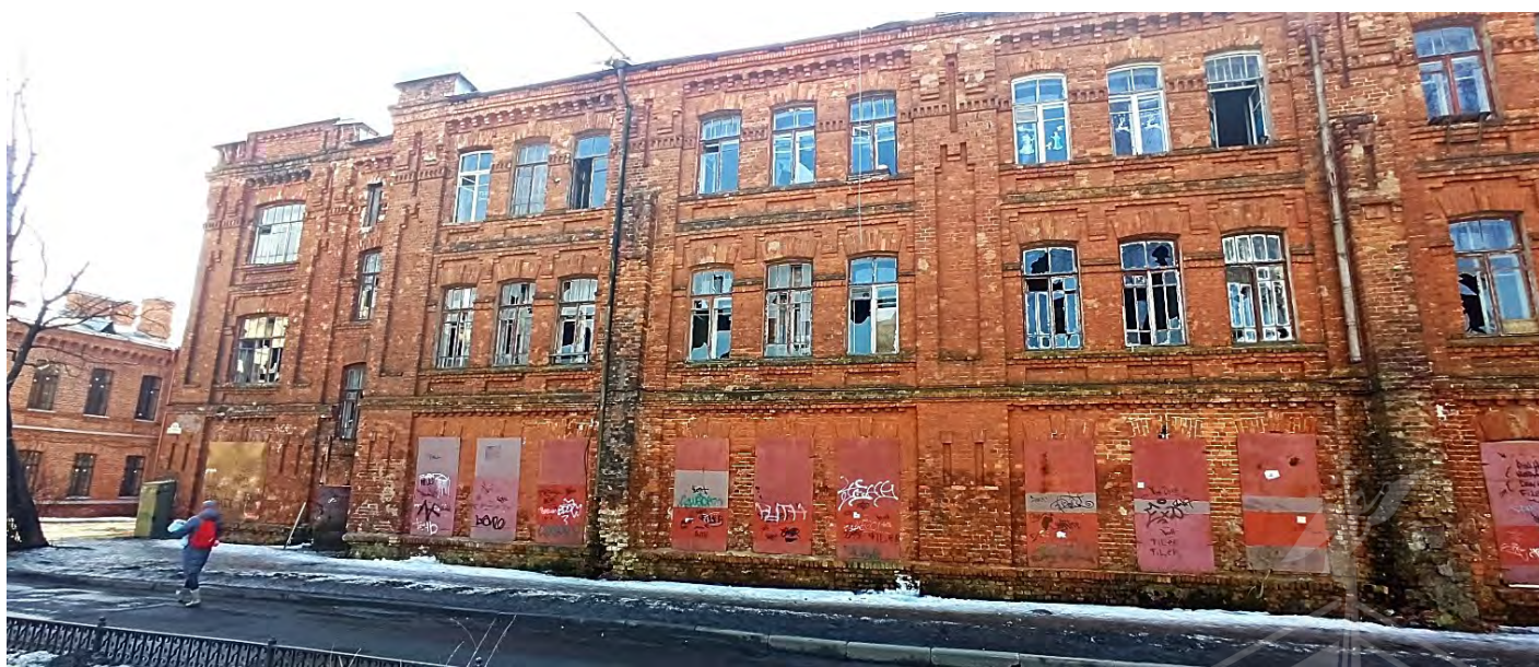
Фото 2. Вид на восточную часть северного фасада
