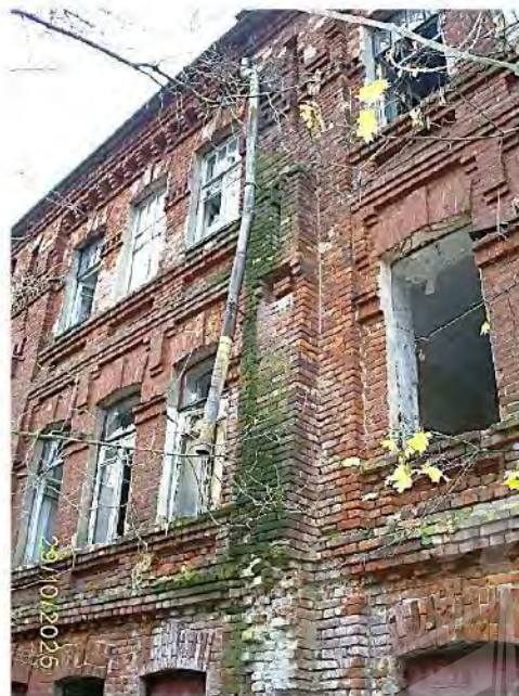
Фото 47. Часть южного фасада
