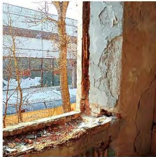
Фото 20. Один из оконных проемов на 2 этаже
