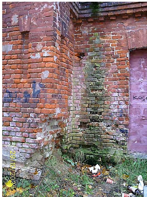
Фото 44. Часть южного фасада
