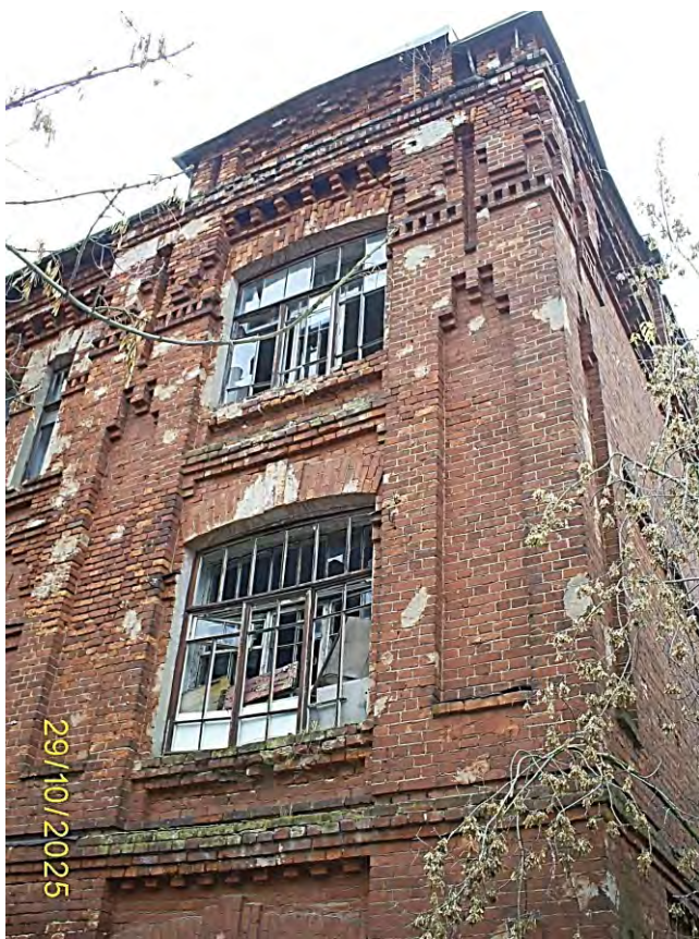
Фото 41. Часть южного фасада
