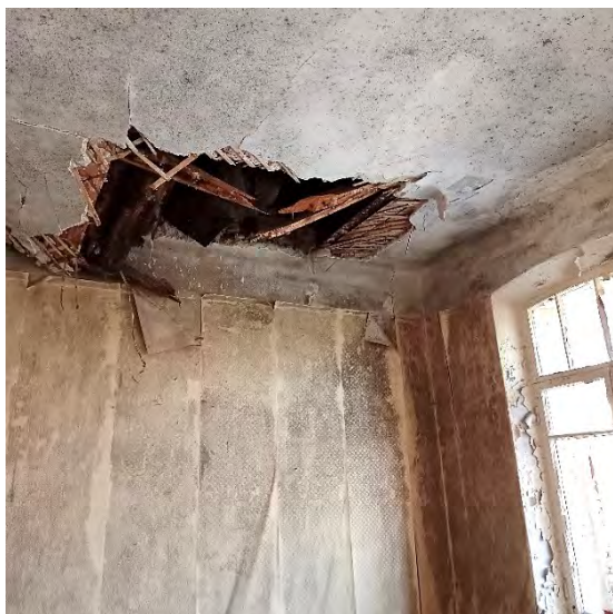
Фото 25. Вид на одно из помещений 3 этажа
