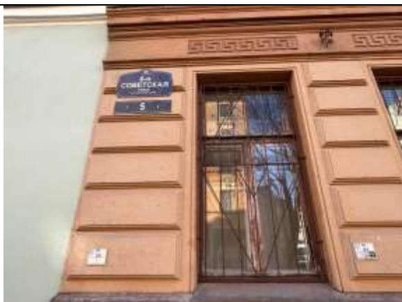
Фото 13. Адрес Объекта оценки
