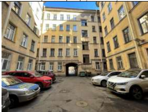
Фото 18. Внутривдворовая территория Объекта оценки
