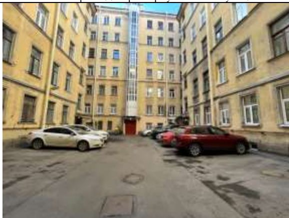
Фото 17. Внутривдворовая территория Объекта оценки
