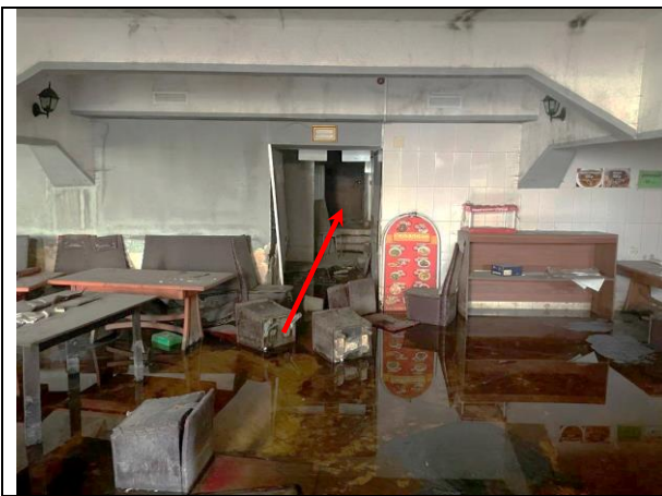
Фото 25. Типичное состояние Объекта оценки
