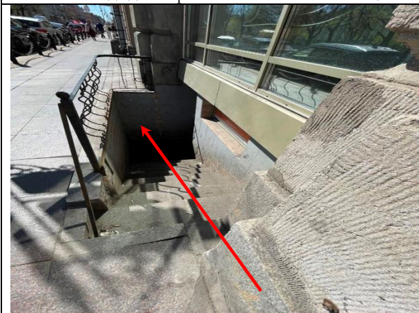
Фото 21. Лестничный проём Объекта оценки
