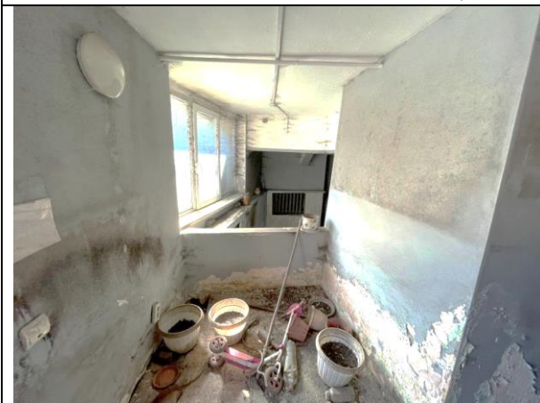
Фото 27. Типичное состояние Объекта оценки
