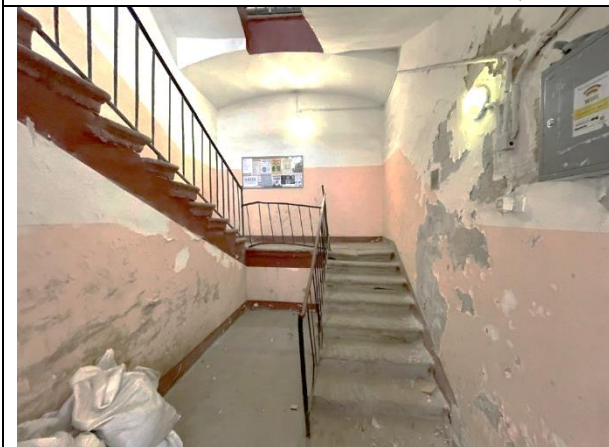
Фото 89. Лестничный проём Объекта оценки, пом.2-Н
