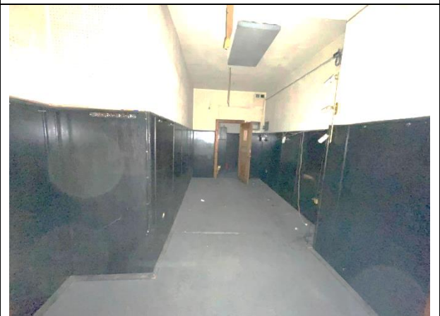
Фото 68. Типичное состояние Объекта оценки
