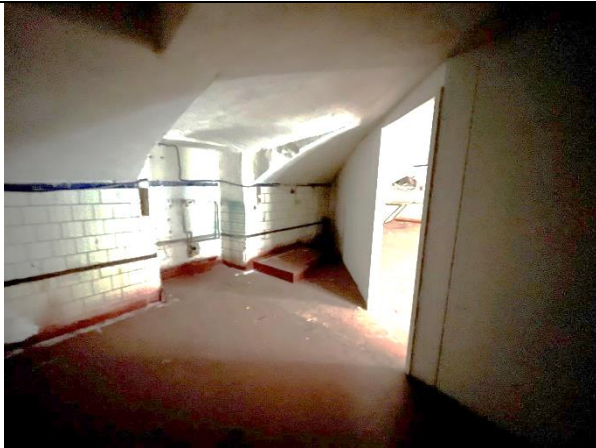
Фото 57. Типичное состояние Объекта оценки
