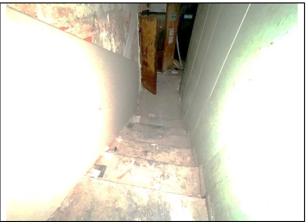
Фото 48. Лестничный проём здания расположения Объекта оценки, пом.2-Н
