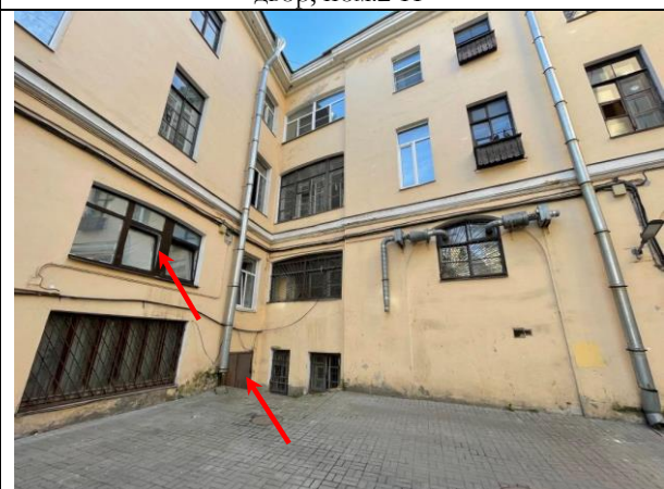
Фото 92. Оконная и входная группа Объекта оценки
