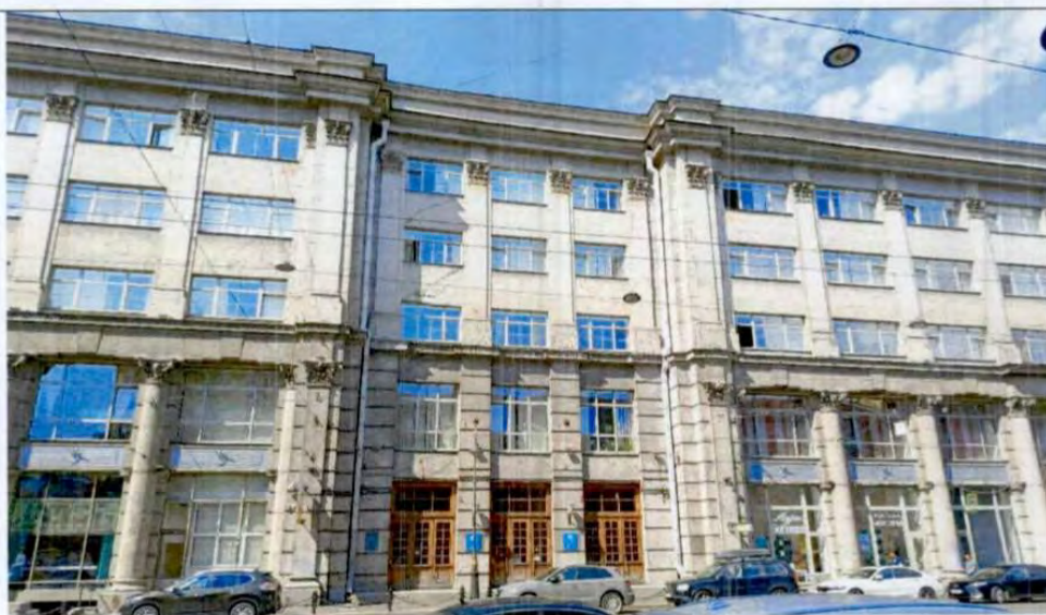
3. Фрагмент лицевого фасада
