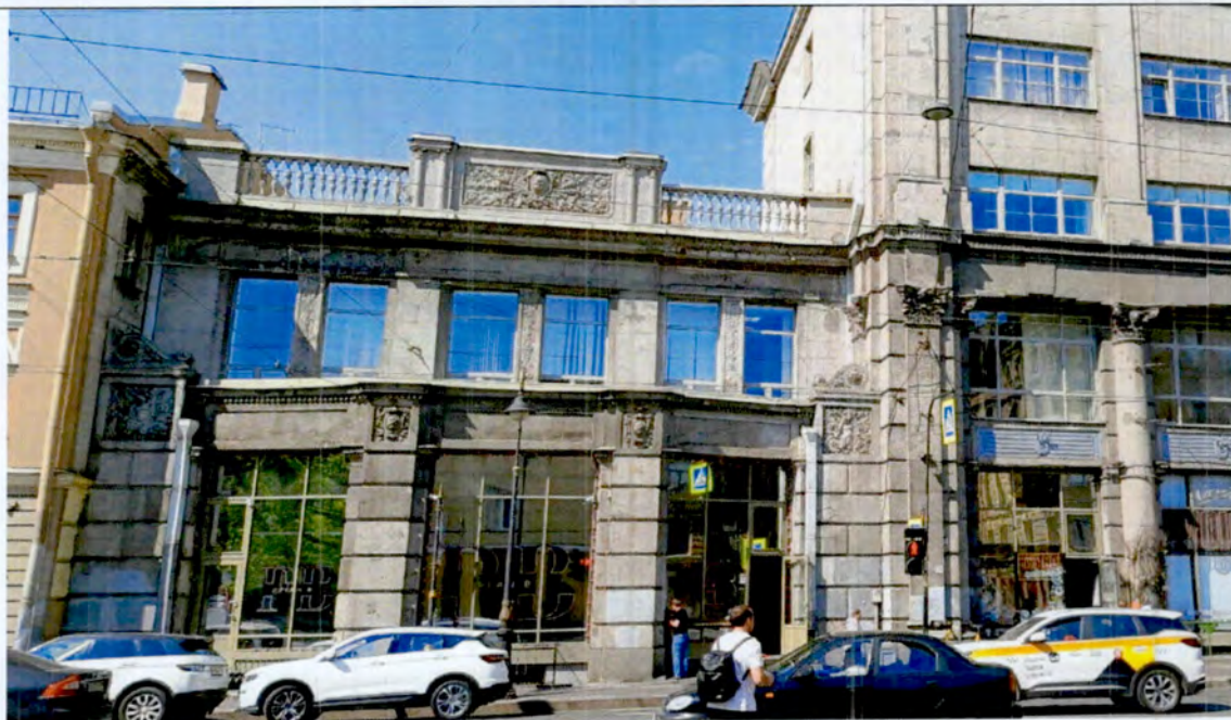
1. Фрагмент лицевого фасада
