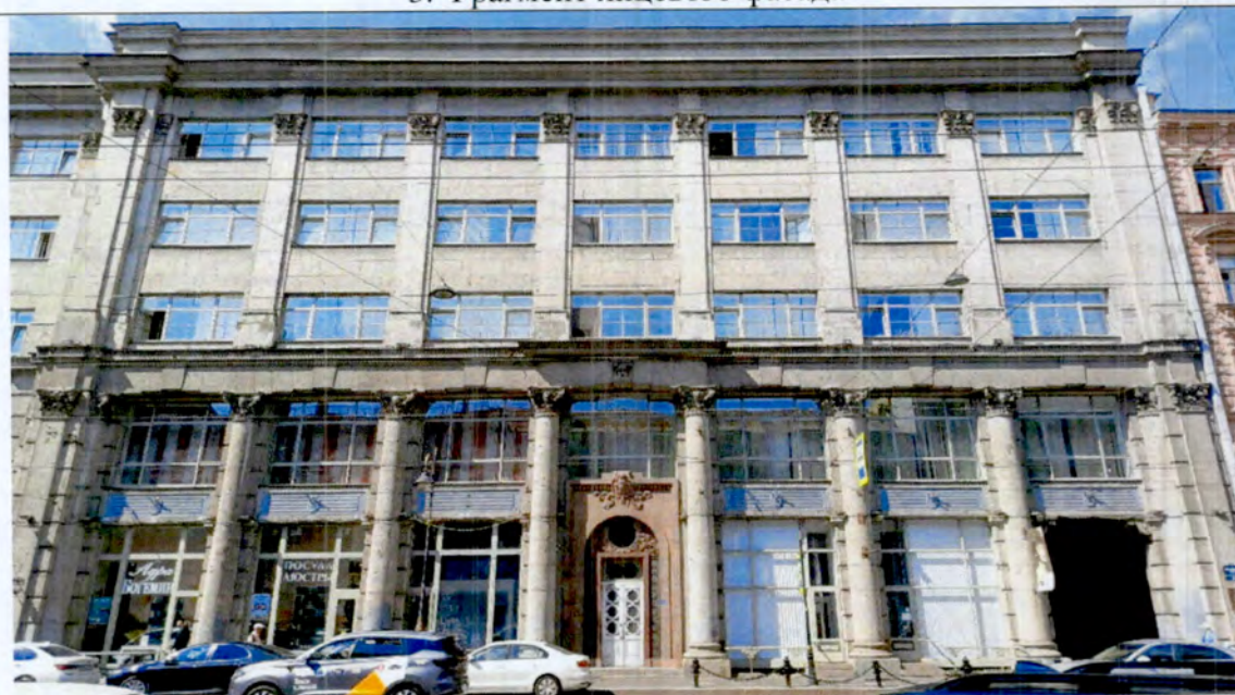
4. Фрагмент лицевого фасада
