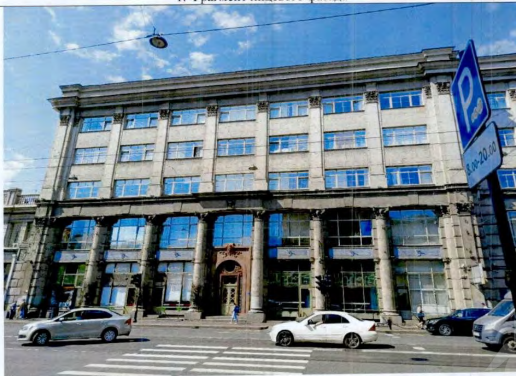
2. Фрагмент лицевого фасада
