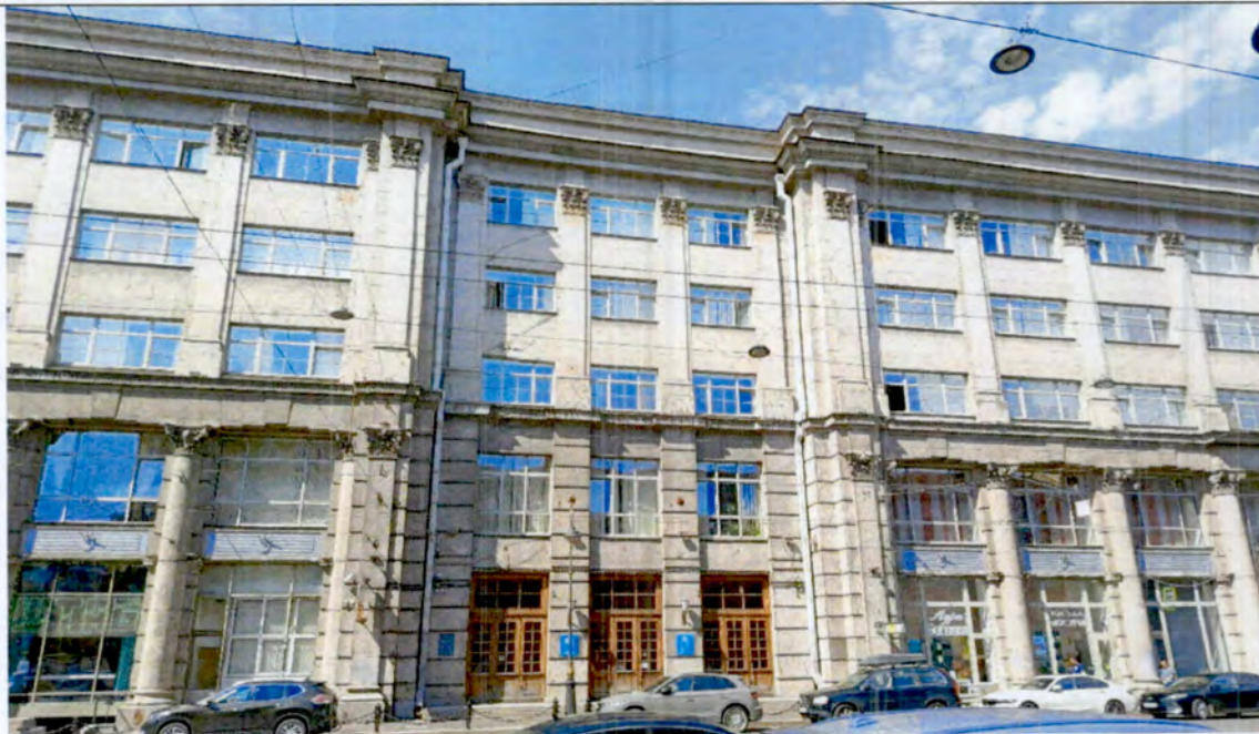
3. Фрагмент лицевого фасада
