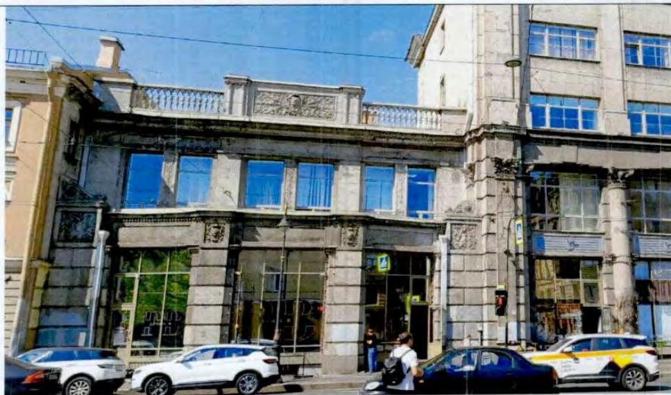
1. Фрагмент лицевого фасада
