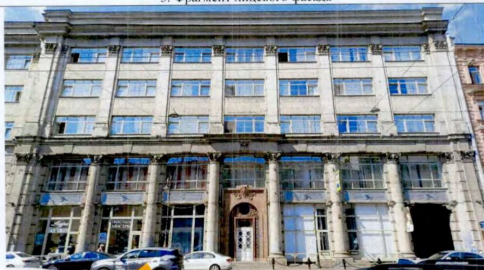
4. Фрагмент лицевого фасада
