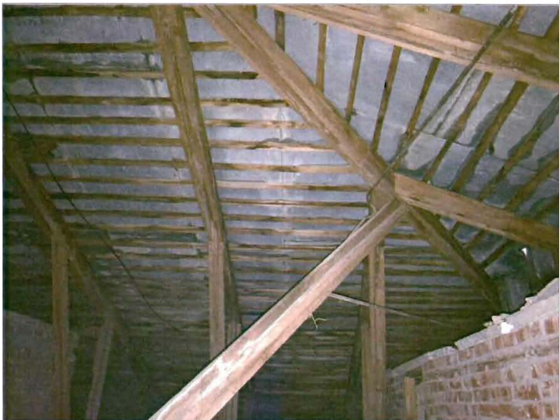
7. Стропильная система. Фрагмент.
