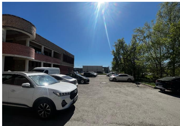
Фото 3. Ближайшее окружение. Дворовая территория
