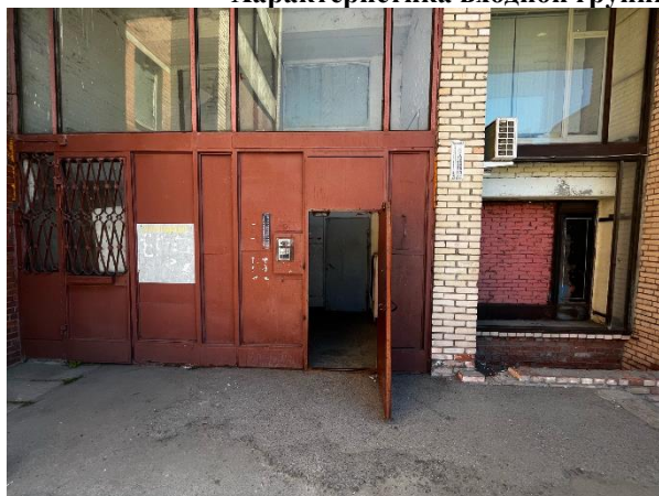
Фото 5. Общий вход с улицы
