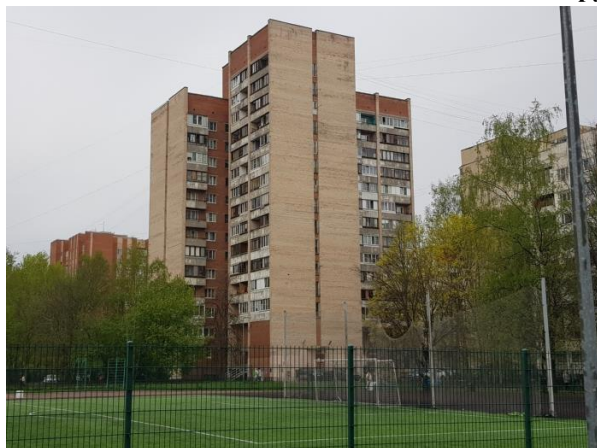
Фото 1. Вид здания, в котором расположен Объект оценки
