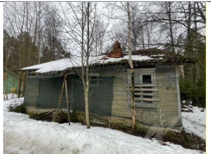
Фото 2. Общий вид Объекта оценки со стороны Еловой переулка.
