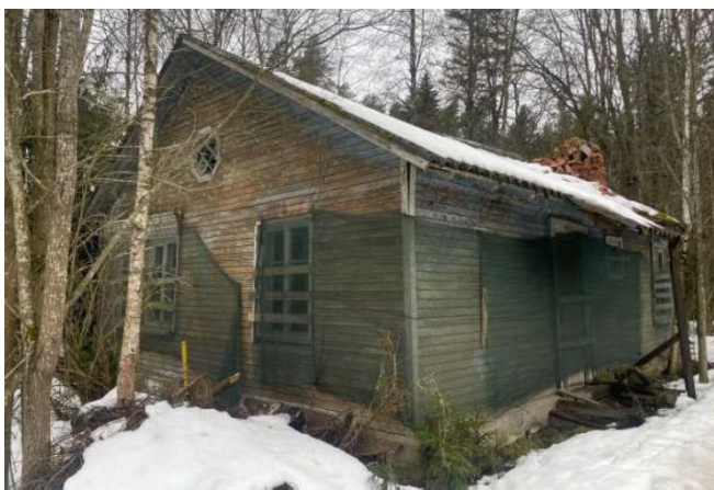
Фото 1. Общий вид Объекта оценки со стороны лового переулка. Точка подключения к газоснабжению.
