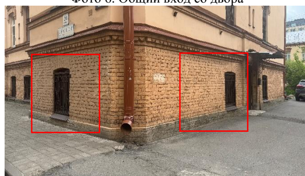
Фото 8. Вид окон Объекта оценки
