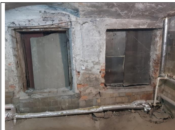
Фото 15. Внутреннее состояние Объекта оценки
