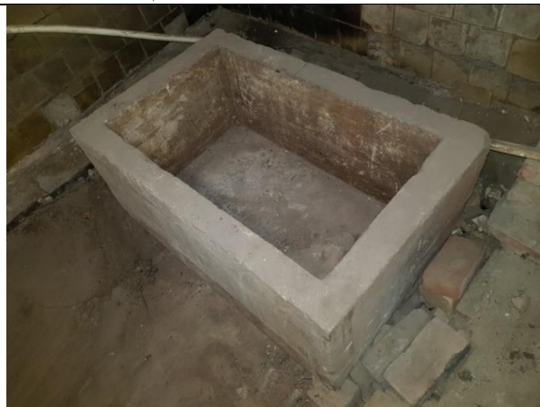
Фото 10. Внутреннее состояние Объекта оценки
