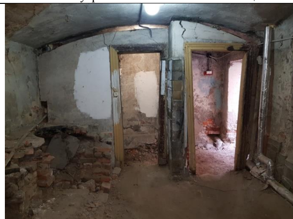
Фото 11. Внутреннее состояние Объекта оценки
