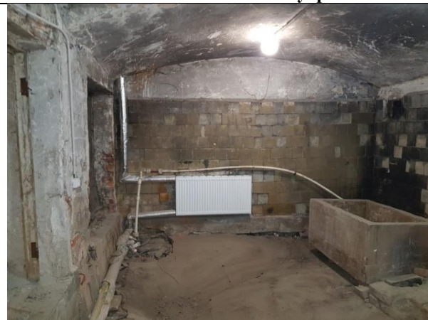
Фото 9. Внутреннее состояние Объекта оценки
