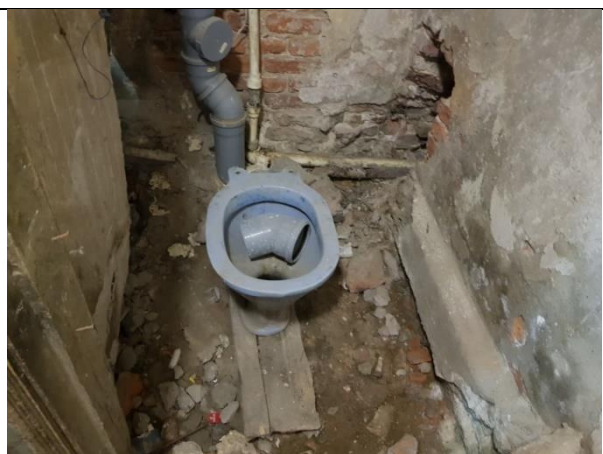
Фото 16. Внутреннее состояние Объекта оценки
