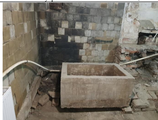
Фото 13. Внутреннее состояние Объекта оценки
