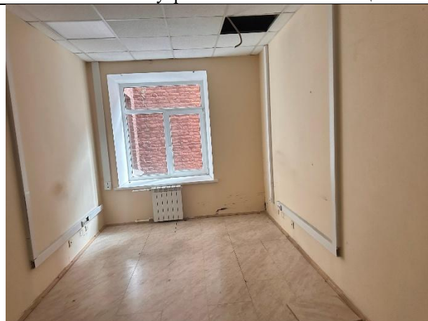
Фото № 13 – Внутреннее состояние помещения
