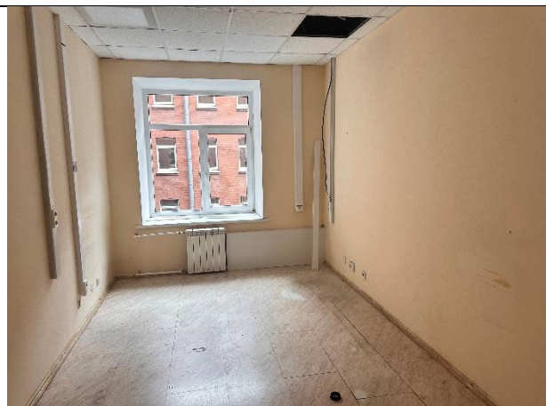
Фото № 16 – Внутреннее состояние помещения
