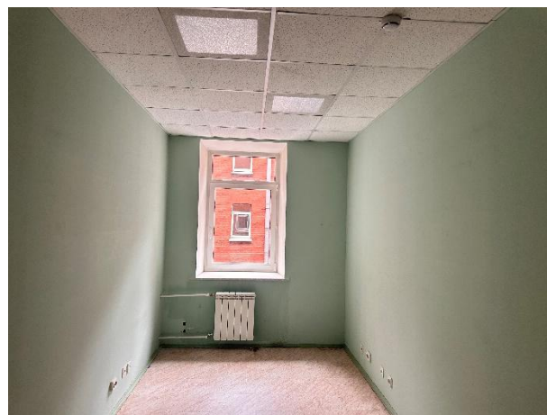
Фото № 10 – Внутреннее состояние помещения
