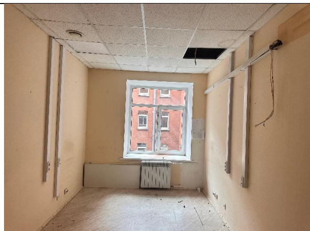
Фото № 24 – Внутреннее состояние помещения
