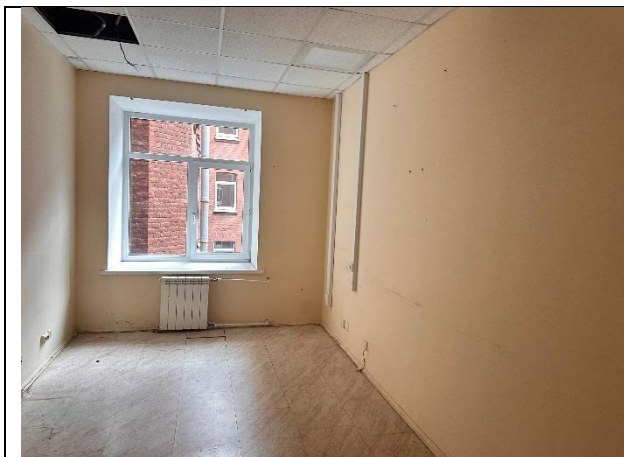
Фото № 15 – Внутреннее состояние помещения
