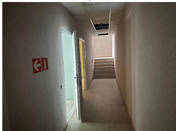
Фото № 9 – Внутреннее состояние помещения
