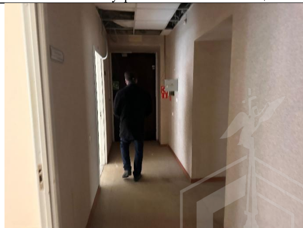
Фото № 14 – Внутреннее состояние помещения
