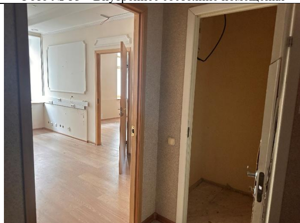
Фото № 18 – Внутреннее состояние помещения
