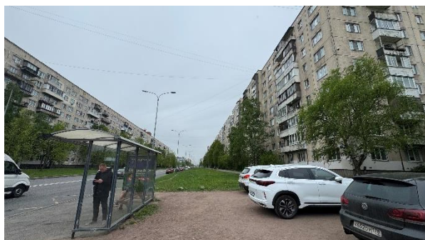
Фото 3. Ближайшее окружение. Дворовая территория
