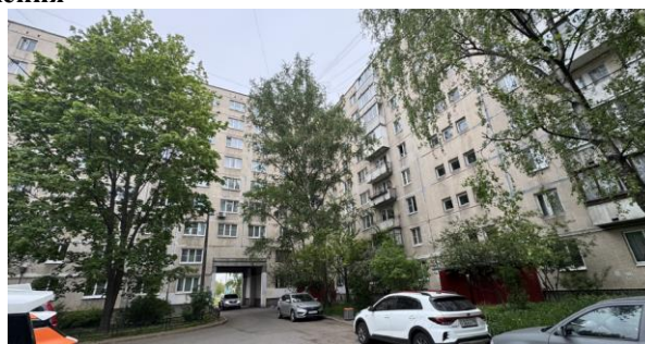
Фото 2. Ближайшее окружение. Дворовая территория
