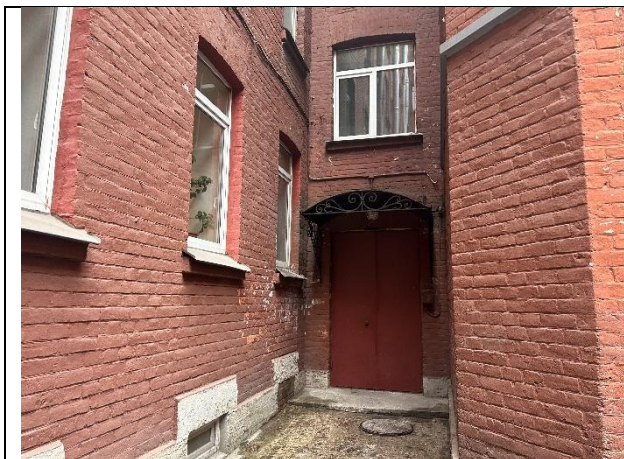
Фото № 7 – Общий вход со двора
