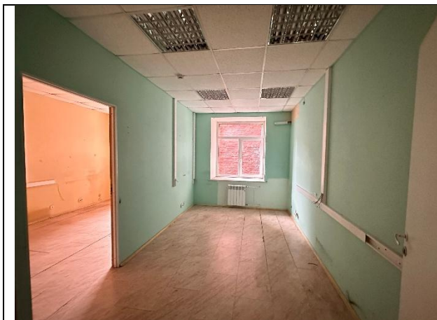
Фото № 15 – Внутреннее состояние помещения
