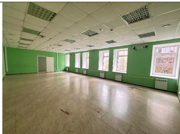
Фото № 16 – Внутреннее состояние помещения
