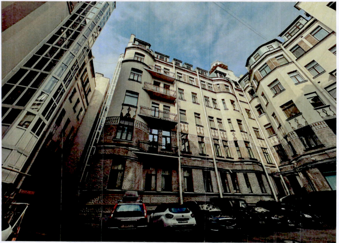
4. Восточный дворовой фасад объекта культурного наследия (литера А). Фото от 02.09.2024.
