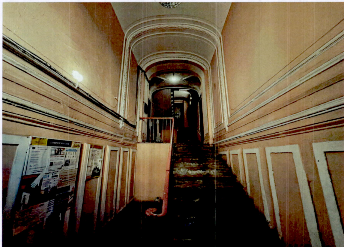
6. Помещение лестницы 2ЛК объекта культурного наследия (литера А). Фото от 03.09.2024.
