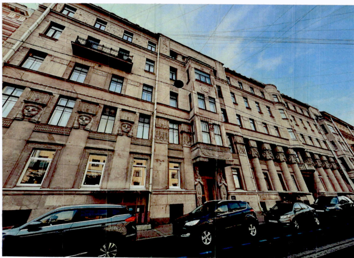
1. Северный лицевой фасад объекта культурного наследия (литера А). Фото от 02.09.2024.
