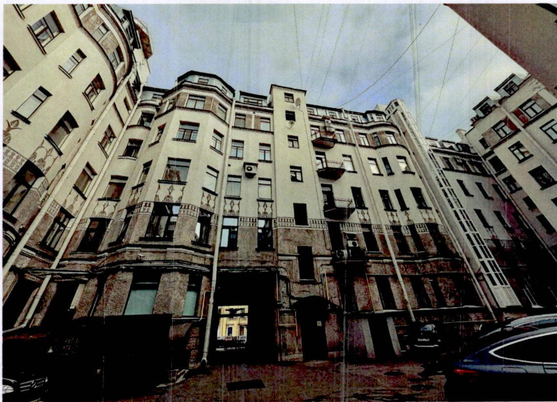
2. Южный дворовой фасад объекта культурного наследия (литера А). Фото от 02.09.2024.
