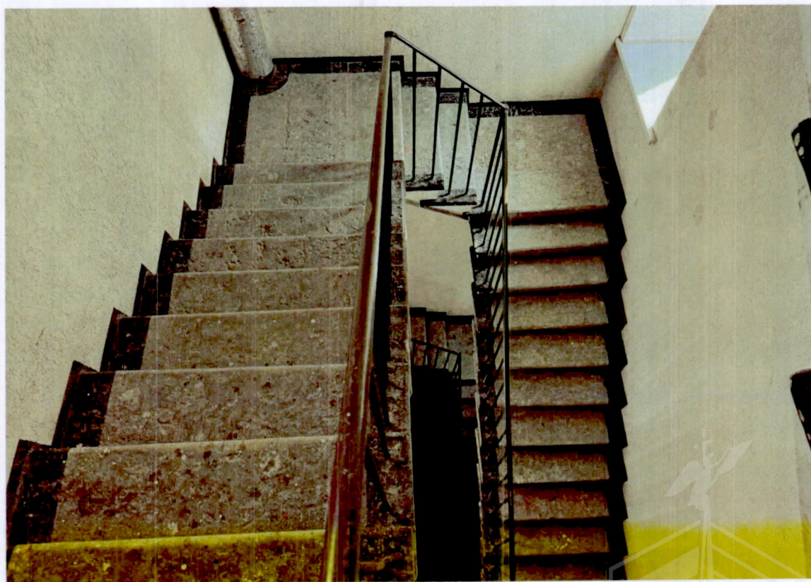
7. Помещение лестницы 7ЛК объекта культурного наследия (литера А). Фото от 03.09.2024.
