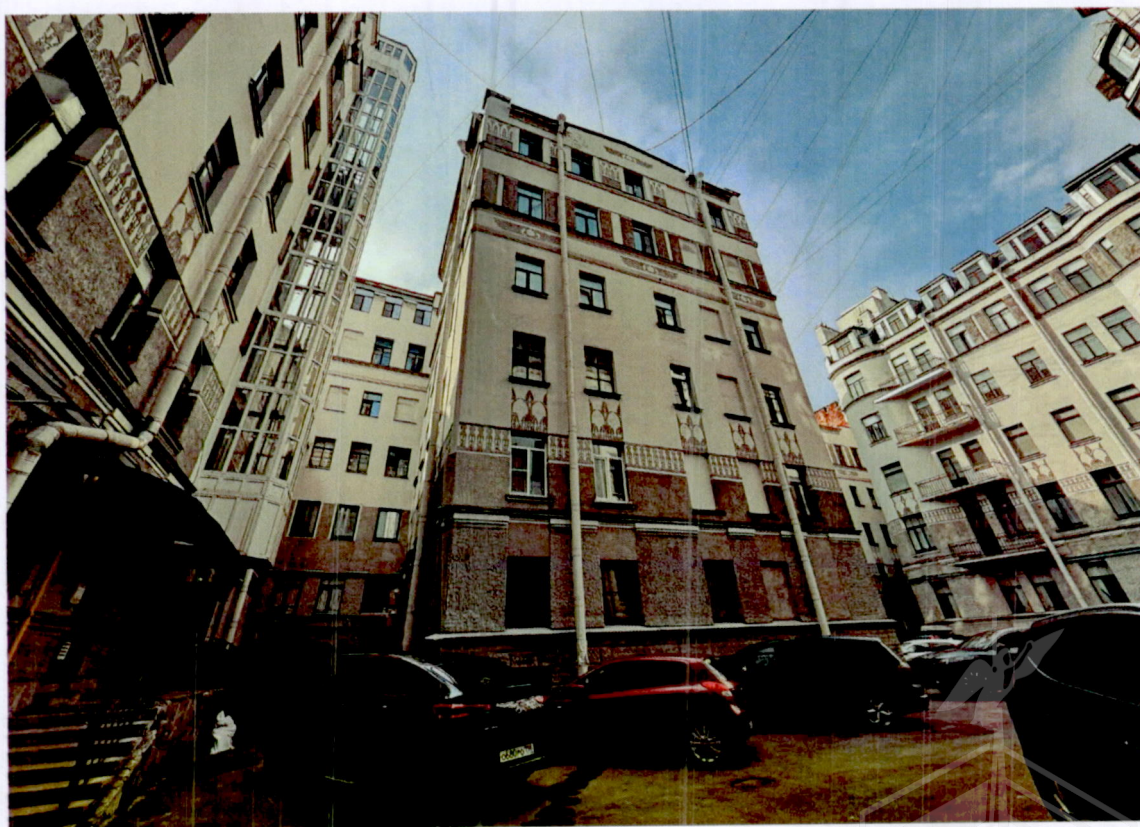
3. Северный дворовой фасад объекта культурного наследия (литеры Б, В). Фото от 02.09.2024.
