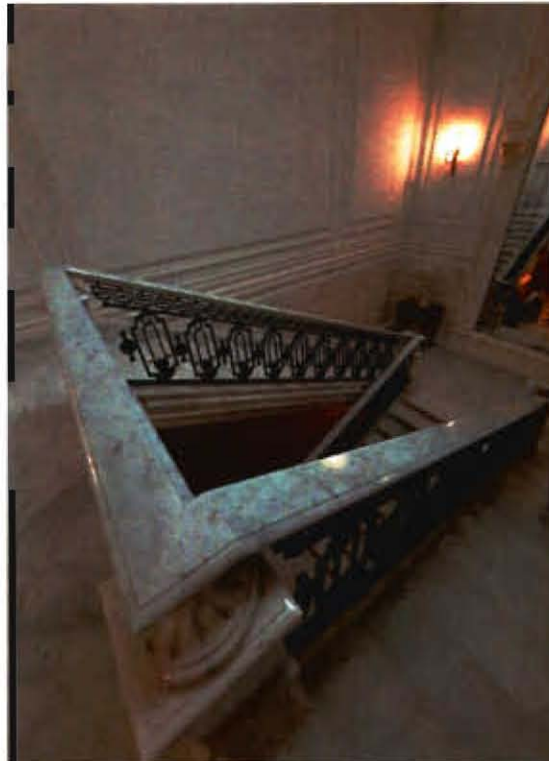
Фото 29. Лестница 6-ЛК. Фото выполнено 23.06.2025.
