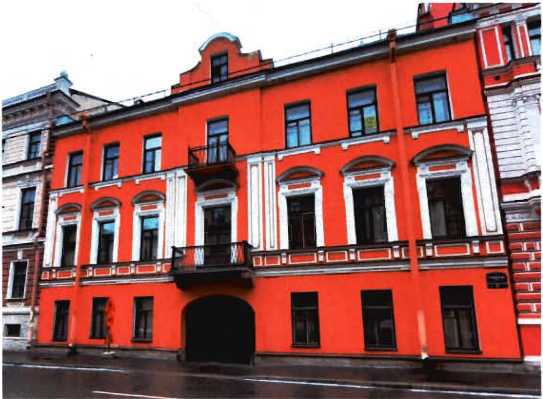
Фото № 5. Южный лицевой фасад по Галерной улице. Фото выполнено 13.03.2025.
