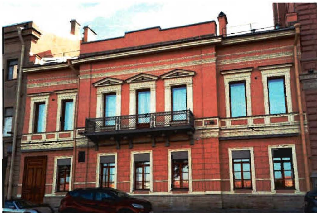
Фото № 1. Северный лицевой фасад по Английской набережной. Фото выполнено 27.09.2023.
