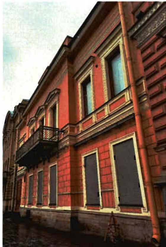
Фото 4. Фрагмент объекта культурного наследия. Северный лицевой фасад по Английской набережной. Фото выполнено 13.03.2025.
