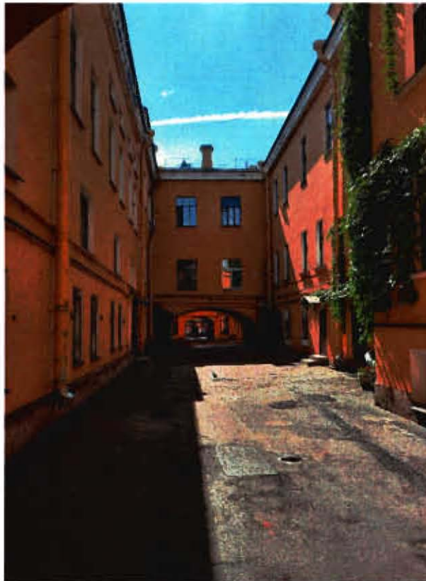
Фото 12. Фрагмент объекта культурного наследия. Вид с севера (второй двор). Фото выполнено от 23.06.2025.
