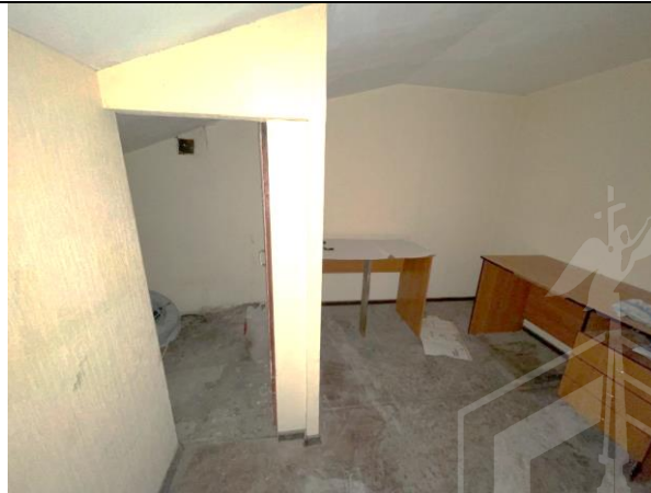
Фото 20. Типичное состояние Объекта оценки
