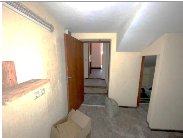
Фото 18. Типичное состояние Объекта оценки
