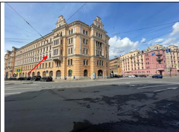
Фото 13. Вид здания расположения Объекта оценки
