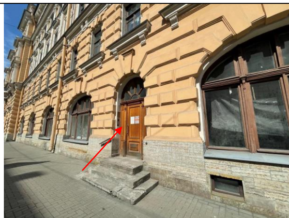
Фото 14. Входная группа здания расположения Объекта оценки
