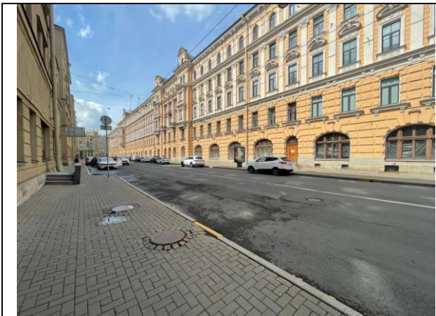
Фото 5. Ближайшее окружение Объекта оценки вход со стороны проспекта Бакунина)
