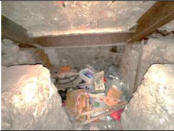
Фото 27. Типичное состояние Объекта оценки
