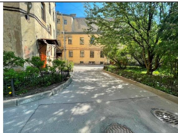
Фото 13. Внутривдворовая территория Объекта оценки
