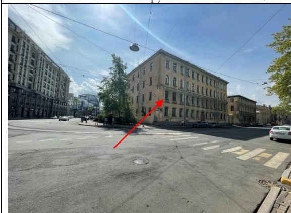
Фото 9. Вид здания расположения Объекта оценки
