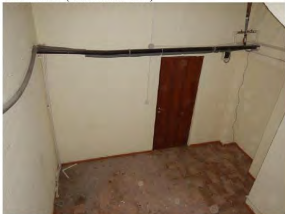
Фото №15 (ч.п.3 пом. 8-Н)
