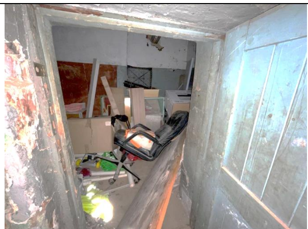
Фото 24. Типичное состояние Объекта оценки
