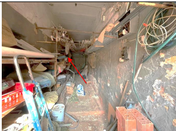
Фото 22. Типичное состояние Объекта оценки
