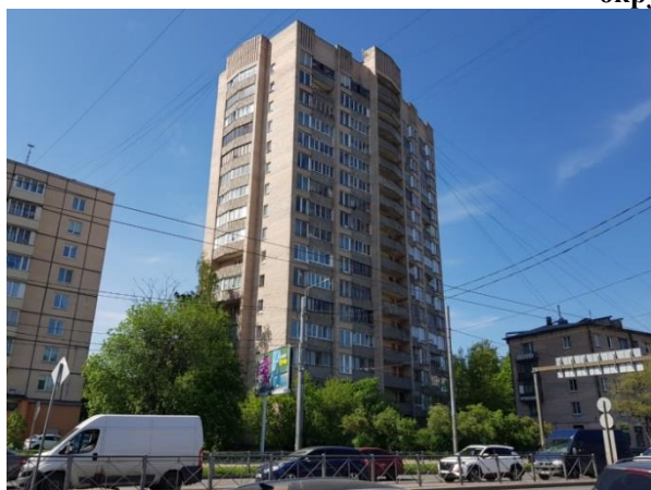
Фото 1. Вид здания, в котором расположен Объект оценки
