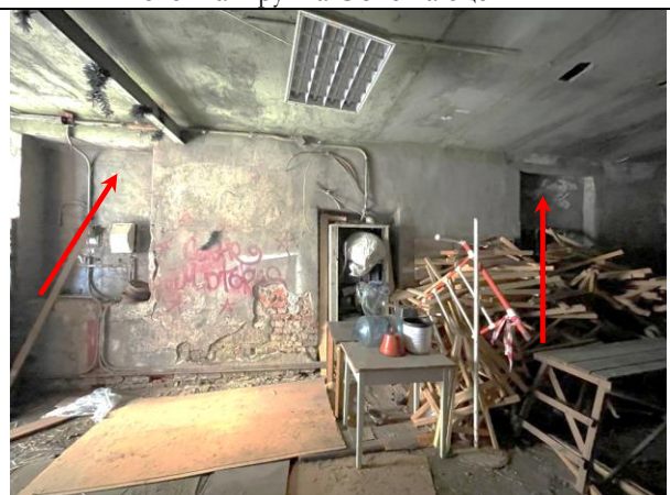
Фото 18. Типичное состояние Объекта оценки, входная и оконная группа Объекта оценки
