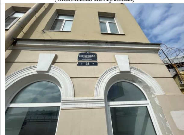
Фото 7. Адрес здания, расположенного рядом с Объектом оценки
