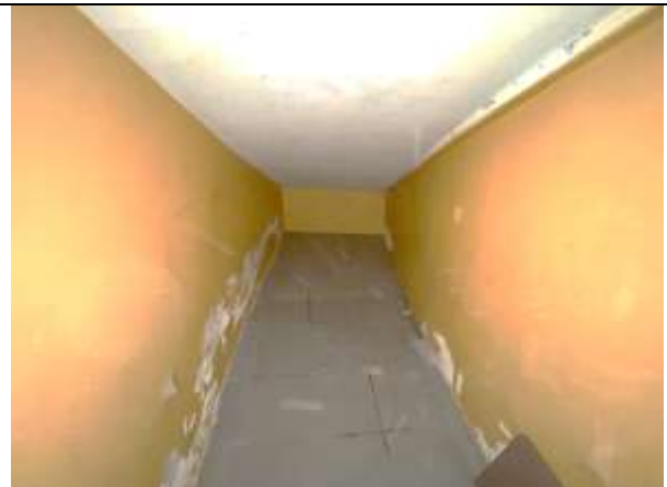
Фото 20. Типичное состояние Объекта оценки
