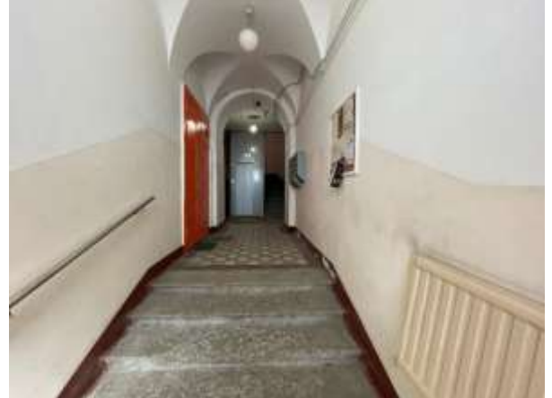
Фото 12. Лестничный проём здания расположения Объекта оценки
