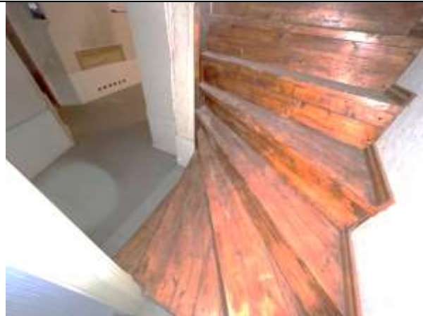
Фото 27. Типичное состояние Объекта оценки
