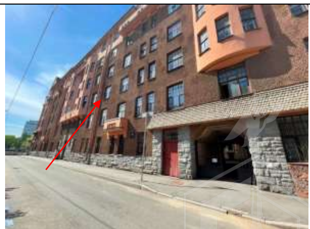
Фото 8. Вид здания расположения Объекта оценки
