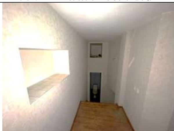
Фото 31. Типичное состояние Объекта оценки
