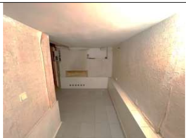
Фото 18. Типичное состояние Объекта оценки
