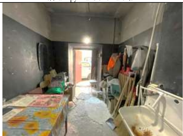
Фото 12. Типичное состояние Объекта оценки
