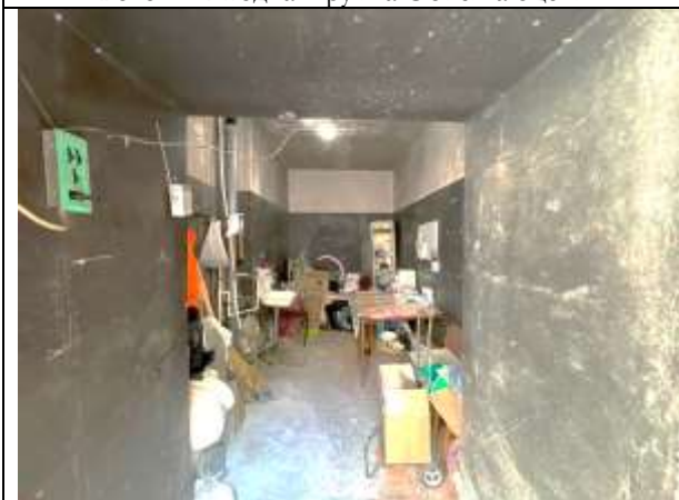
Фото 13. Типичное состояние Объекта оценки
