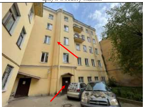
Фото 10. Вид здания расположения Объекта оценки, входная группа Объекта оценки
