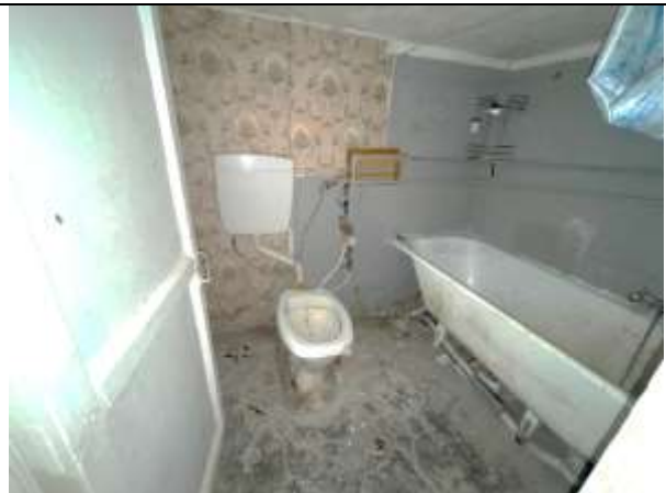
Фото 26. Типичное состояние Объекта оценки
