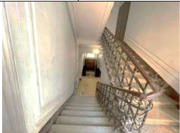
Фото 12. Лестничный проём Объекта оценки
