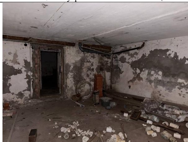
Фото № 10 – Внутреннее состояние помещения
