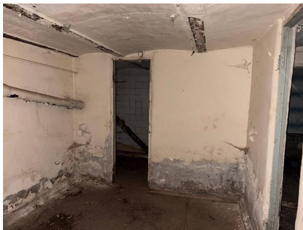
Фото № 13 – Внутреннее состояние помещения
