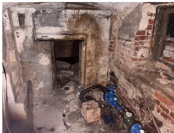
Фото № 8 – Внутреннее состояние помещения
