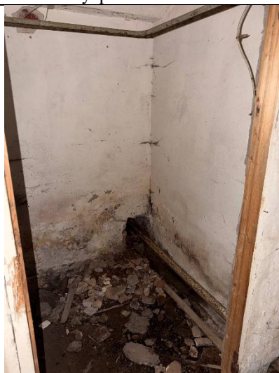
Фото № 16 – Внутреннее состояние помещения
