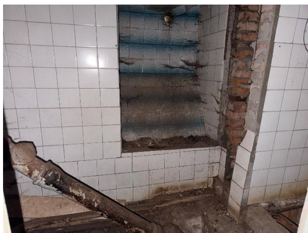
Фото № 15 – Внутреннее состояние помещения
