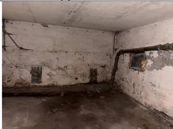
Фото № 11 – Внутреннее состояние помещения
