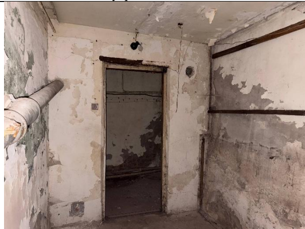
Фото № 12 – Внутреннее состояние помещения
