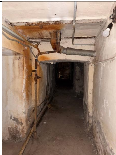
Фото № 14 – Внутреннее состояние помещения
