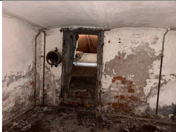
Фото № 19 – Внутреннее состояние помещения
