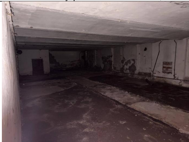
Фото № 17 – Внутреннее состояние помещения
