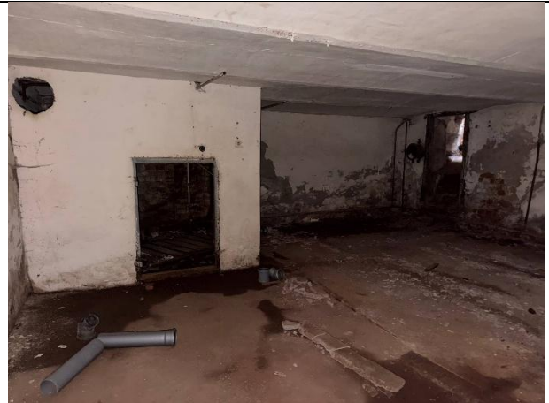
Фото № 20 – Внутреннее состояние помещения
