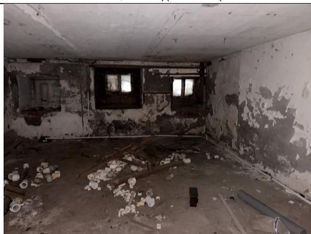
Фото № 9 – Внутреннее состояние помещения
