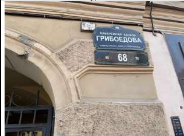
Фото 7. Адрес здания, в котором расположен Объект оценки
