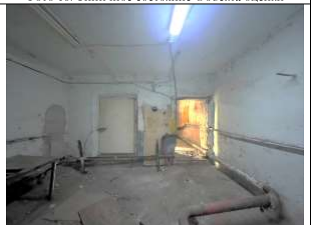
Фото 18. Типичное состояние Объекта оценки
