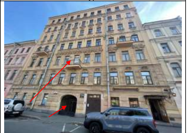
Фото 8. Вид здания, в котором расположен Объект оценки, проход через арку к Объекту оценки
