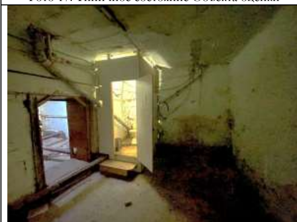
Фото 19. Типичное состояние Объекта оценки
