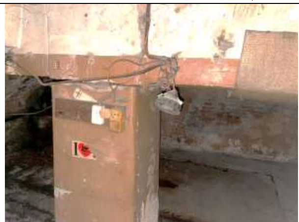
Фото 20. Типичное состояние Объекта оценки
