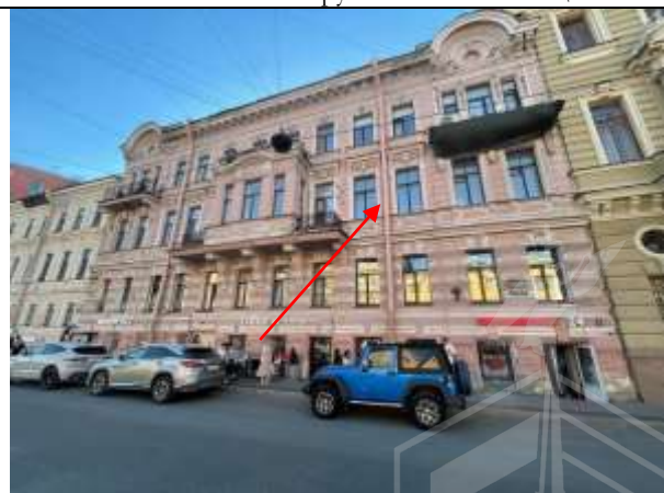
Фото 8. Вид здания, в котором расположен Объект оценки
