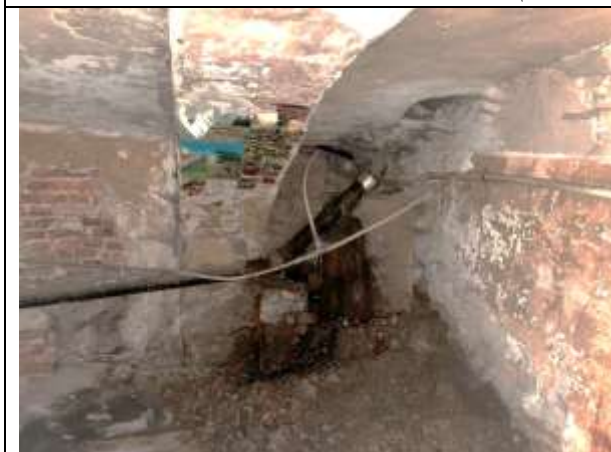
Фото 19. Типичное состояние Объекта оценки
