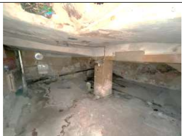
Фото 18. Типичное состояние Объекта оценки
