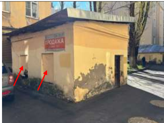
Фото 24. Оконные проемы Объекта оценки
