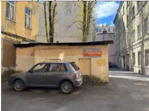
Фото 21. Внутридворовая территория Объекта оценки
