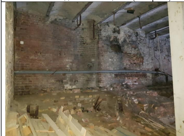
Фото 27. Вид Объекта оценки (литера А)
