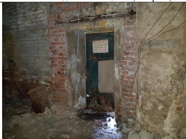
Фото 26. Вид Объекта оценки (литера А)
