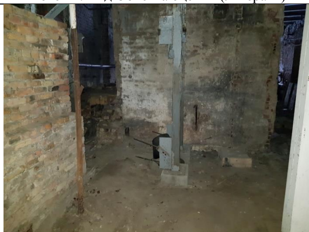
Фото 24. Вид Объекта оценки (литера А)
