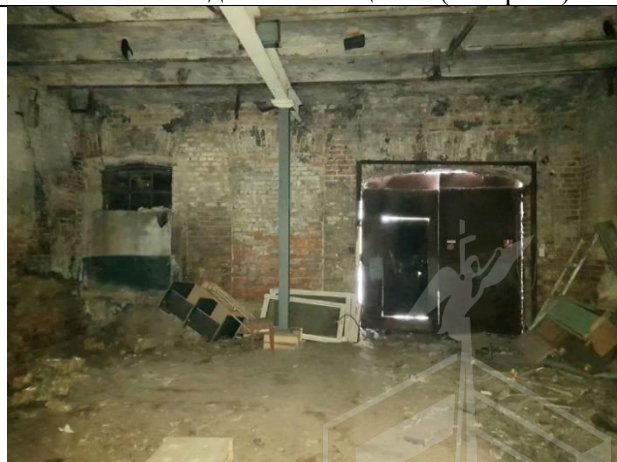
Фото 28. Вид Объекта оценки (литера А)
