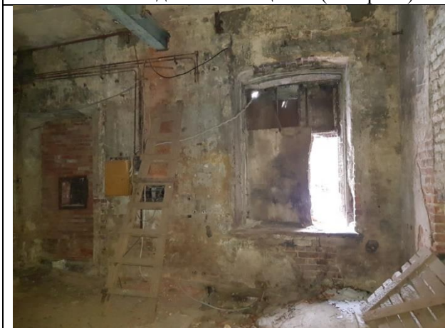
Фото 25. Вид Объекта оценки (литера А)
