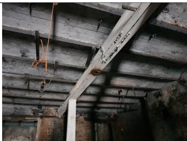
Фото 22. Вид Объекта оценки (литера А)
