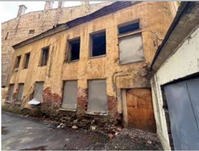
Фото 33. Вид здания расположения Объекта оценки
