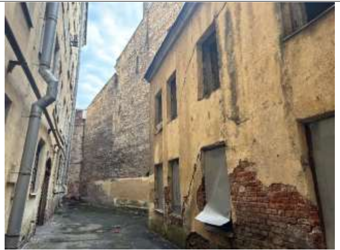
Фото 34. Вид здания расположения Объекта оценки
