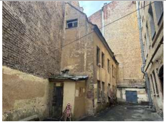
Фото 32. Вид здания расположения Объекта оценки
