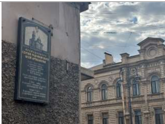
Фото 2. Ближайшее окружение Объекта оценки (Литейный проспект)
