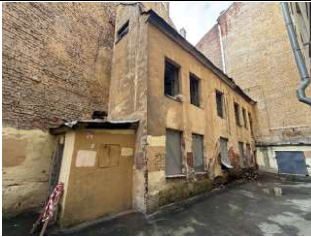
Фото 31. Вид здания расположения Объекта оценки
