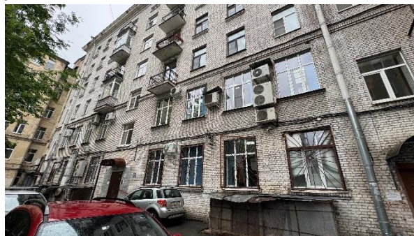
Фото 2. Вид здания, в котором расположен Объект оценки
