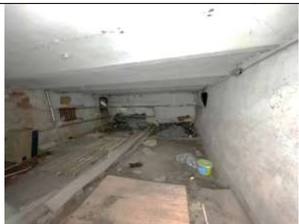
Фото 32. Типичное состояние Объекта оценки
