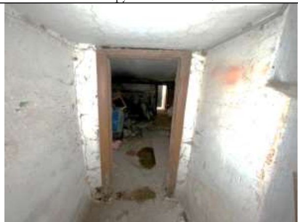
Фото 30. Типичное состояние Объекта оценки
