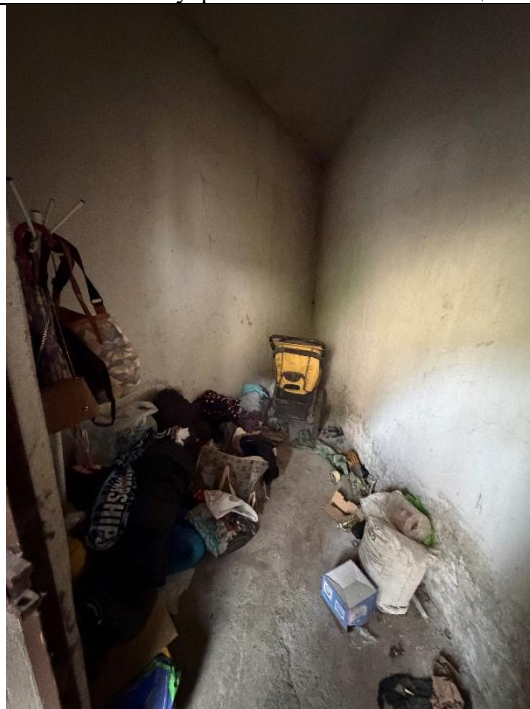
Фото № 8 – Внутреннее состояние помещения
