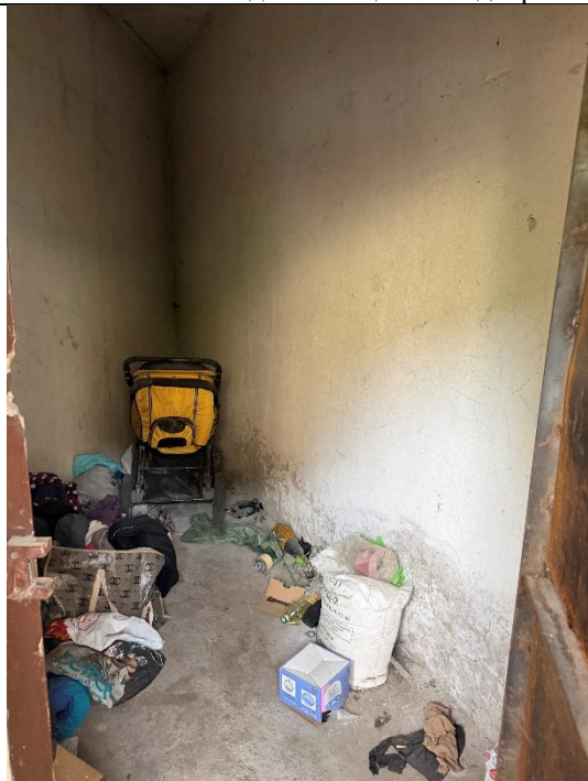
Фото № 7 – Внутреннее состояние помещения
