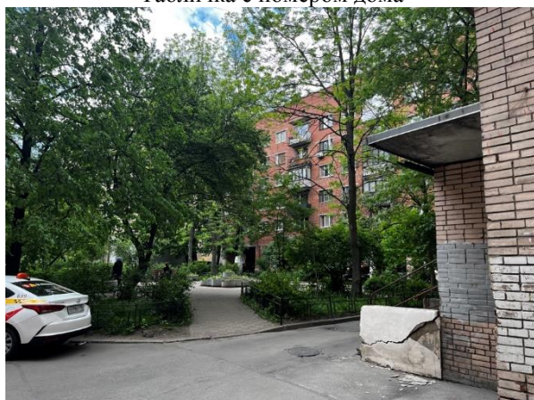
Фото 3. Вид здания Объекта оценки. Дворовая территория
