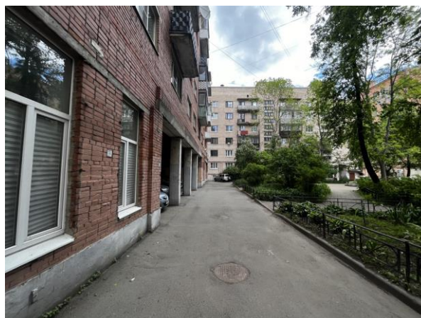
Фото 4. Вид здания Объекта оценки. Дворовая территория
