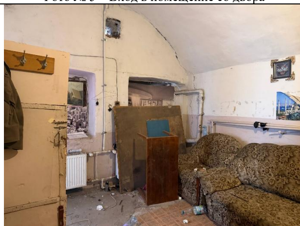
Фото № 7 – Внутреннее состояние помещения
