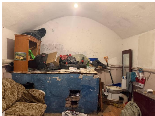
Фото № 6 – Внутреннее состояние помещения
