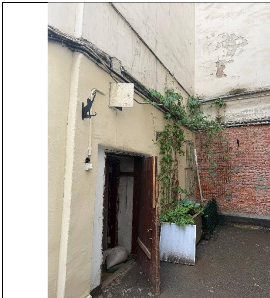
Фото № 5 – Вход в помещение со двора
