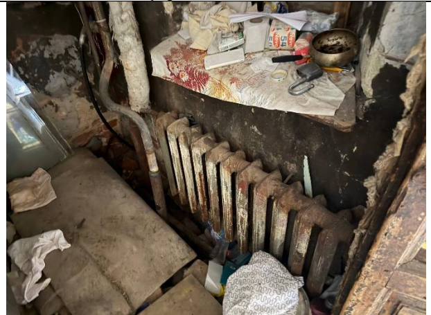
Фото № 8 – Внутреннее состояние помещения
