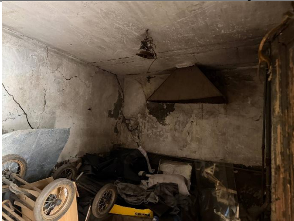
Фото № 7 – Внутреннее состояние помещения
