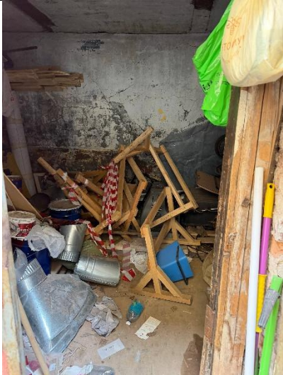
Фото № 5 – Вход в помещение со двора
