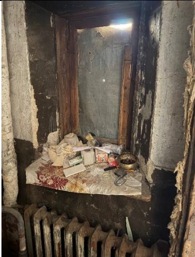
Фото № 9 – Внутреннее состояние помещения
