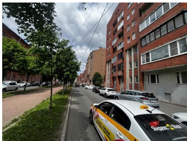
Фото 4. Вид здания Объекта оценки. Ближайшее окружение
