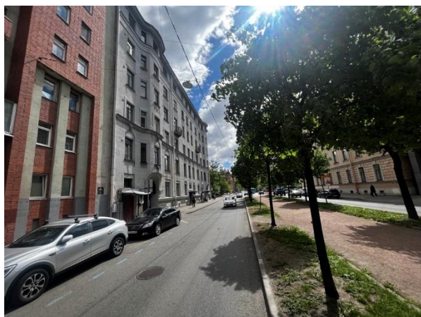
Фото 3. Вид здания Объекта оценки. Ближайшее окружение
