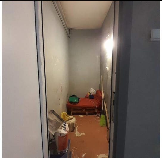
Фото № 6 – Внутреннее состояние помещения
