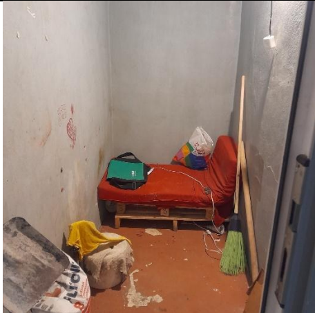
Фото № 9 – Внутреннее состояние помещения
