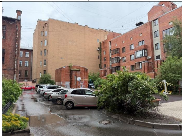
Фото № 4 – Вход в помещение со двора
