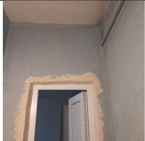
Фото № 10 – Внутреннее состояние помещения
