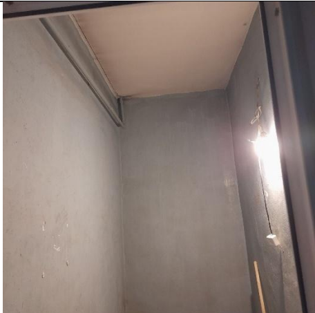
Фото № 7 – Внутреннее состояние помещения
